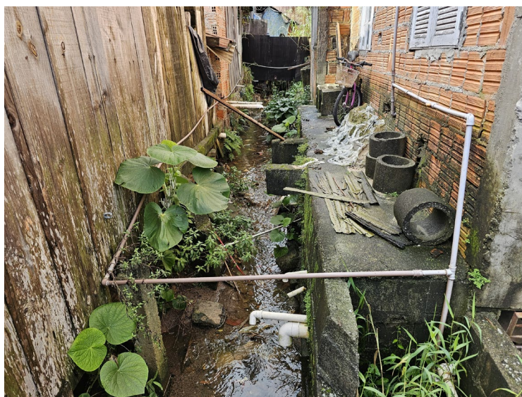
Figura 1 – Curso d'água natural cercado por imóveis e com despejo de rede de esgoto.
