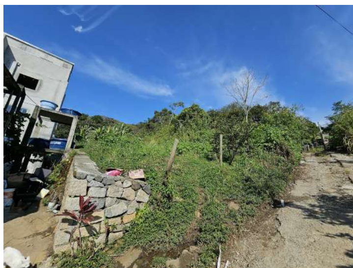
Figura 1 – Muro de contenção feito de blocos de granito e para contenção de área elevada.
