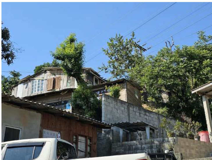
Figura 2 – Sistema de muros de contenção feito de concreto para contenção das áreas inclinadas.
