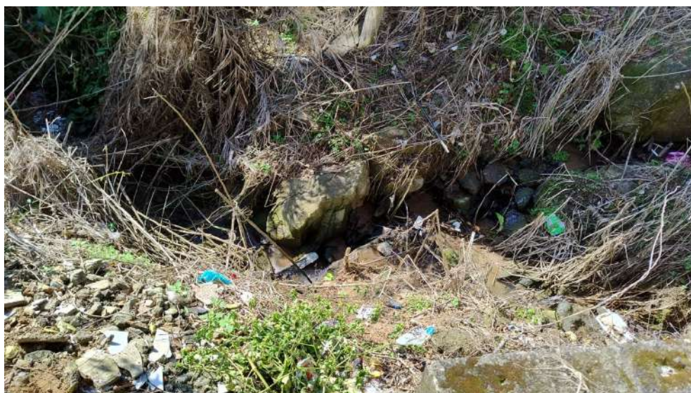
Registro na Comunidade do Mangueirão.
