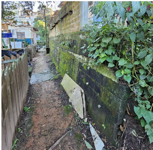
Figura 1 – Muro de contenção de blocos de concreto com drenos do solo feito com canos PVC.
