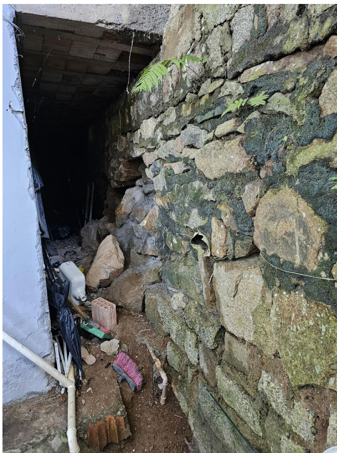
Figura 3 – Muro de contenção de blocos de granito com processo erosivo instalado. Ocorreu queda de blocos do muro e erosão do solo do mesmo, ocasionado por infiltração da água pluvial. Necessita de reparos de sua estrutura e monitoramento.
