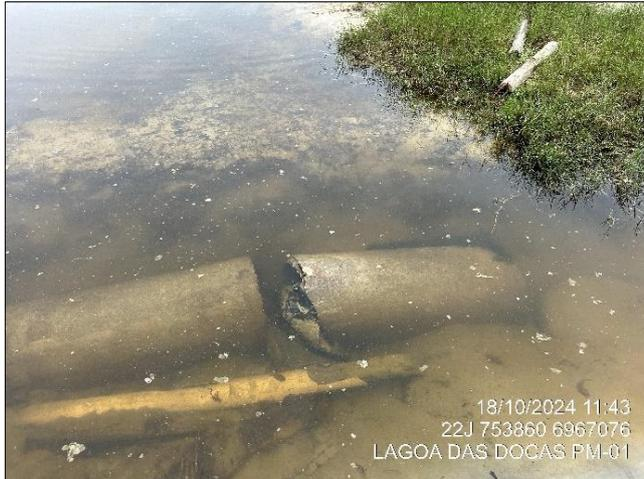
**Figura 6. Registro de tubulação exposta e colapsada.**
