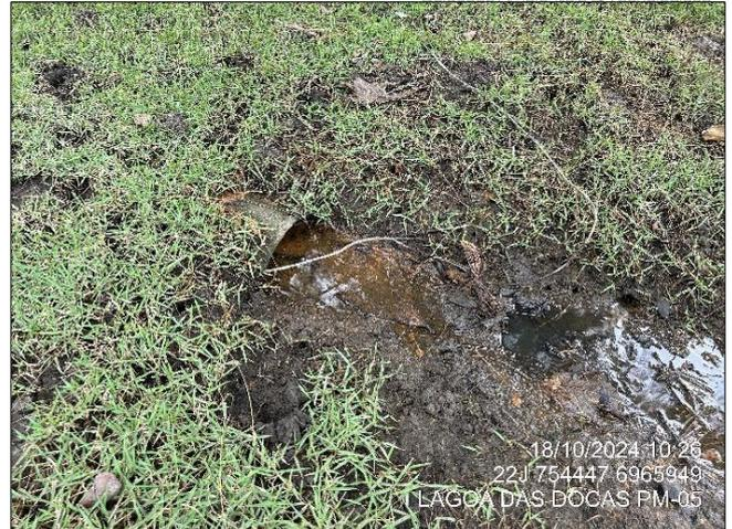
**Figura 7. Ponto de extravasamento de tubulação de drenagem pluvial ou sanitária danificada e parcialmente afogada em área de manguezal.**
