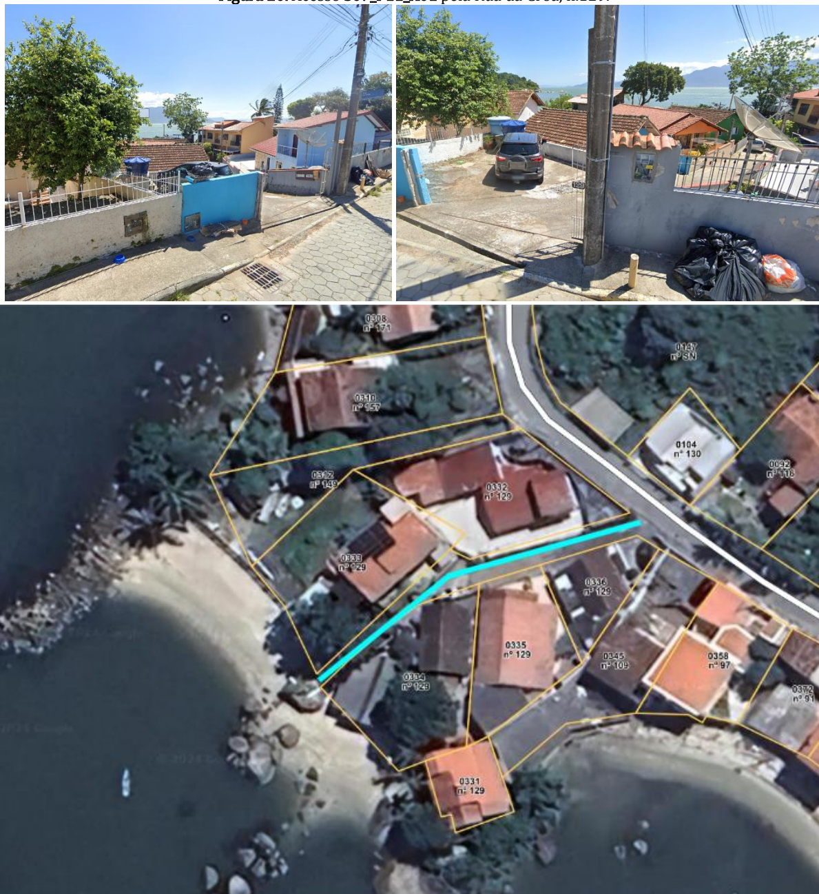
Figura 20. Acesso S07_P11_A01 pela Rua da Croa, n.129.
