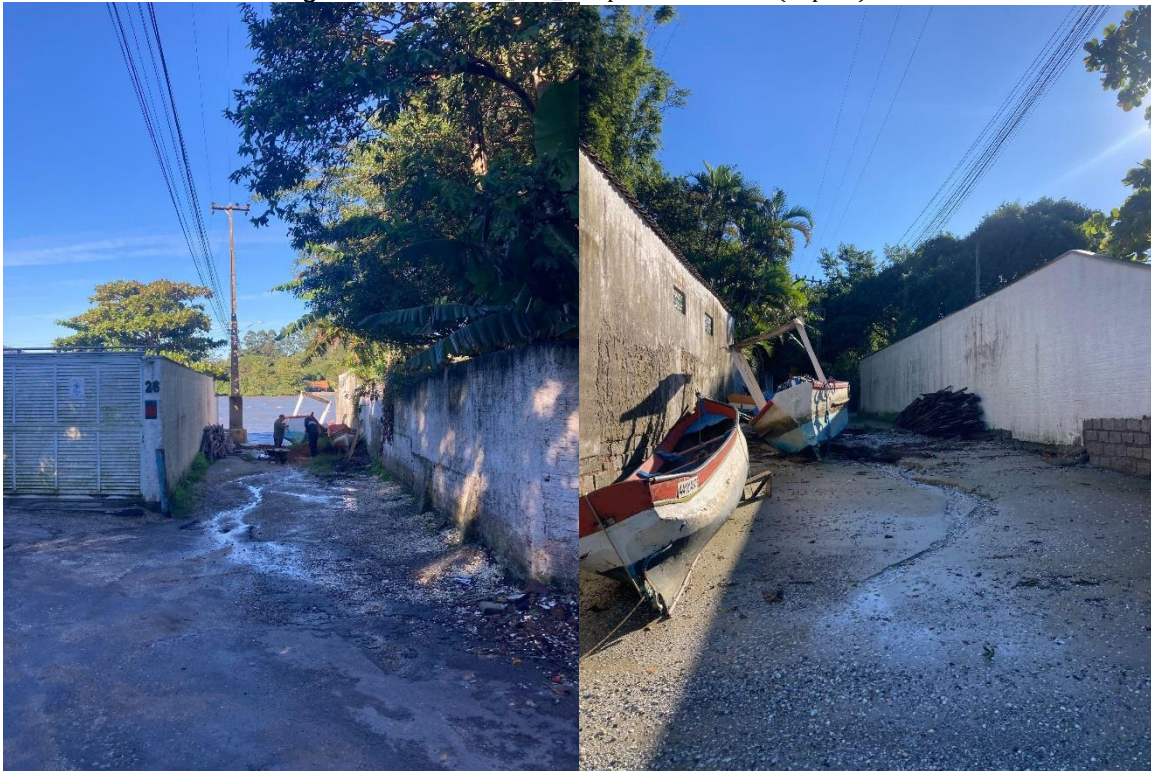
Figura 31. Acesso S07_P13_A09 pela Rua da Ilha (Tapera).
