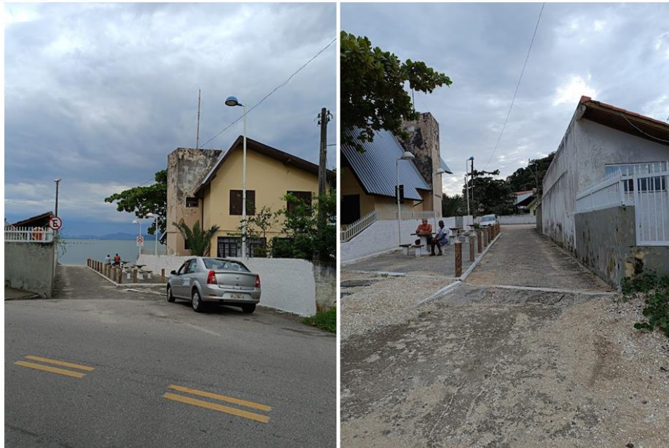
Figura 106. À esquerda visto do acesso S07_P25_A02 da Rodovia Baldicero Filomeno e a imagem à direita, vista da praia praia para a rodovia.
