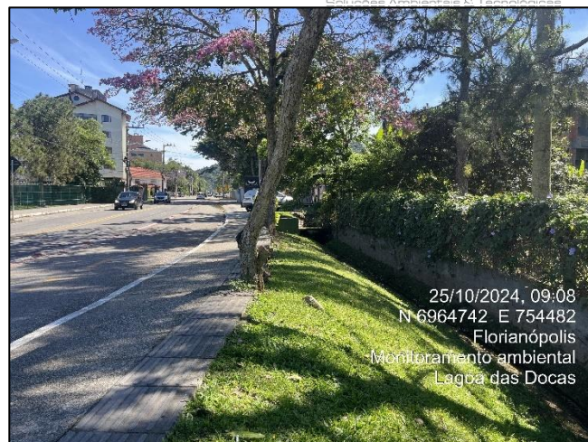
Figura 104. Sistema de drenagem localizado em frente a um condomínio na Avenida Luiz Boiteux Piazza com escoamento em direção à um riacho.
