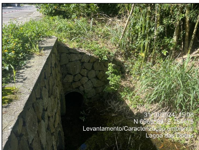
Figura 101. Saída de drenagem localizado nas proximidades de passagem na Avenida Luiz Boiteux Piazza em direção à um riacho sem denominação conhecida.
