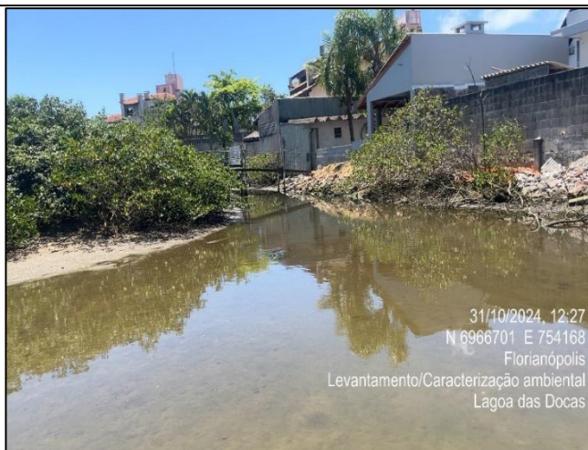
Figura 312. Construções de casas de passarelas feitas nas bordas da lagoa. Acúmulos de materiais de construção civil poluindo o manancial
