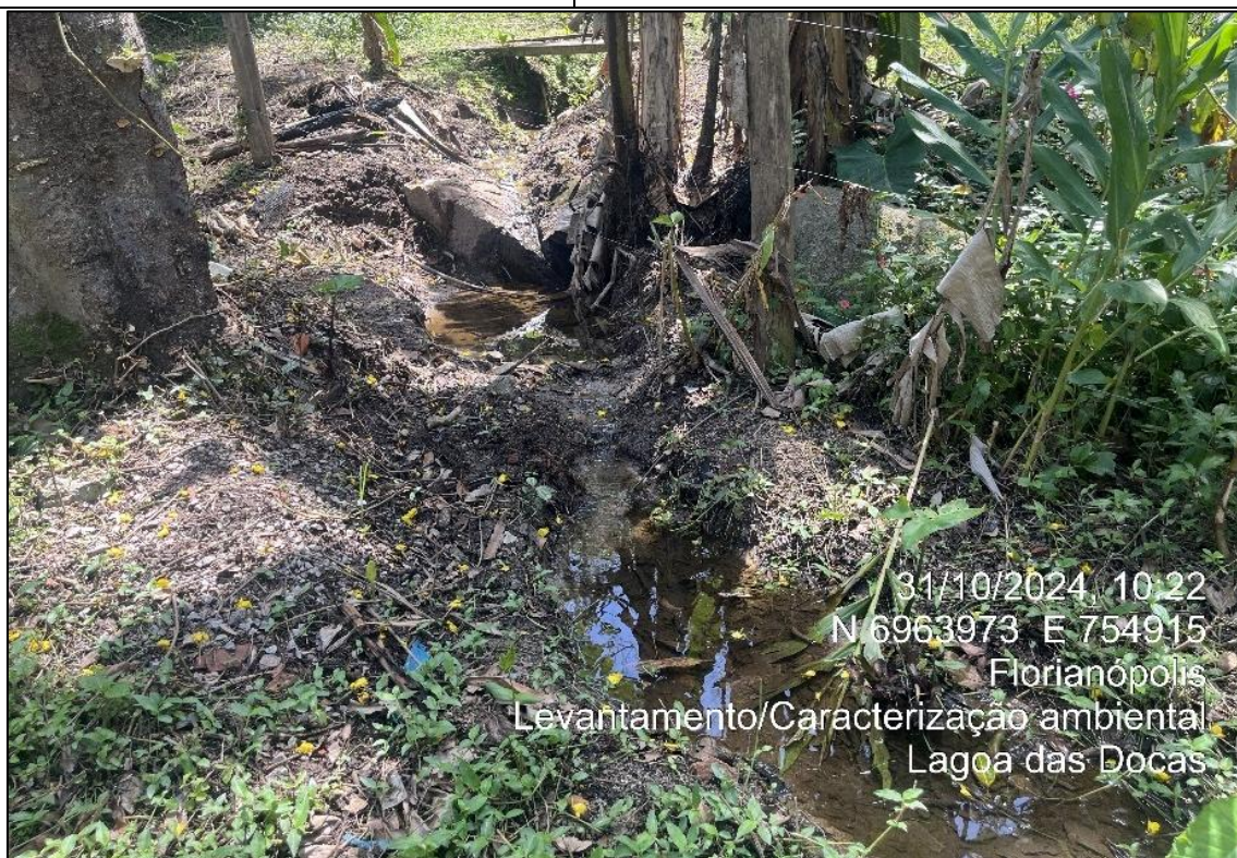
Figura 296. Escoamento de água de possível nascente oriunda de área particular em processo de PRAD pela FLORAM.
