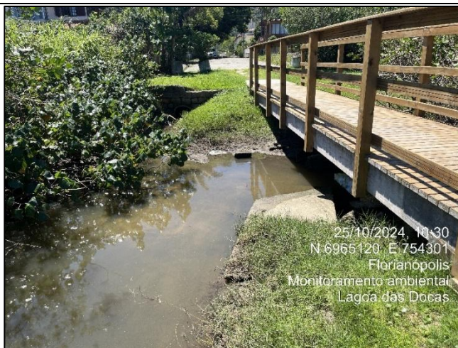
Figura 260. Passarela feita de forma que impactou significativamente o local como um todo.
