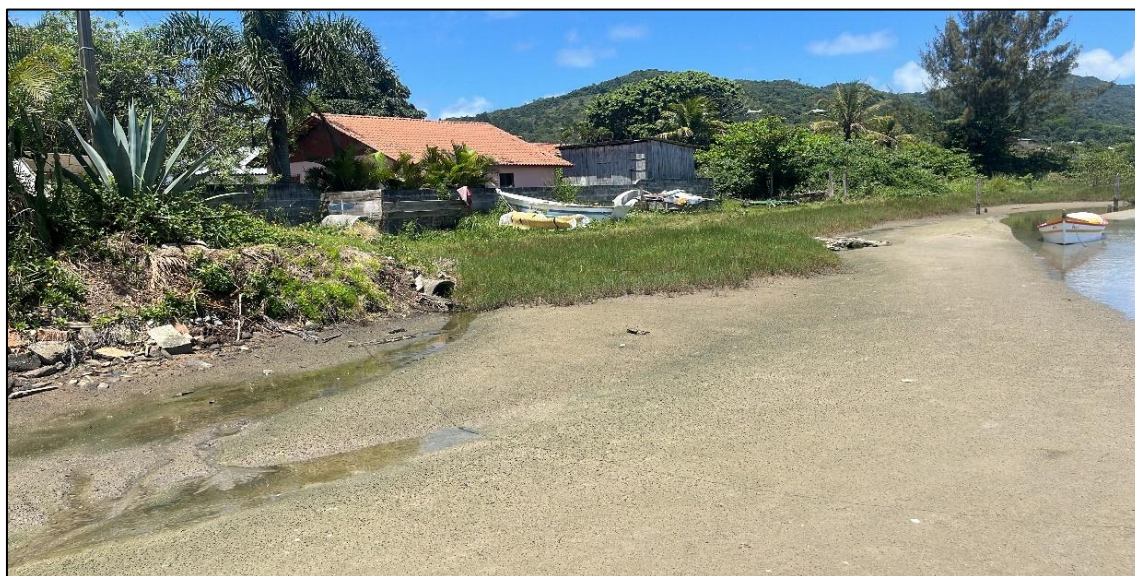
Figura 317. Canal de drenagem escoando águas para dentro da lagoa.
