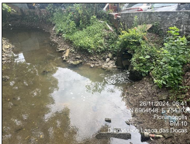
Figura 236. Detalhamento do entorno direto ao ponto do PM10.
