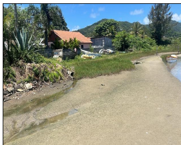
Figura 125. Canalização de drenagem de águas com saída direta para a Lagoa das Docas.
