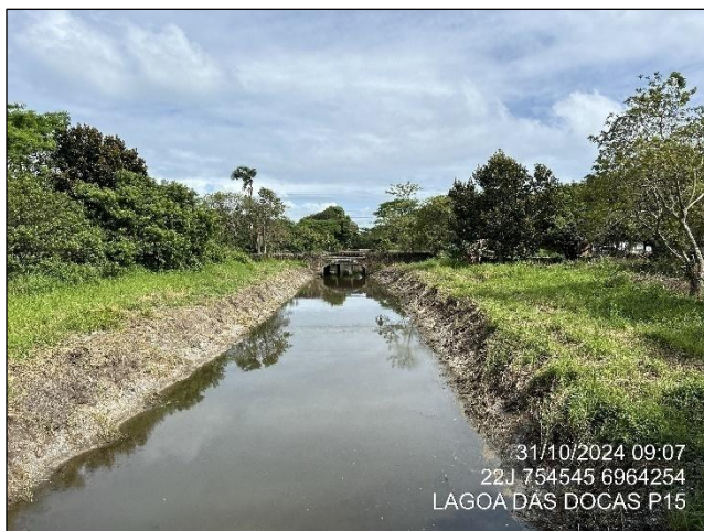
Figura 32. Depósito fluvial composto as margens de trecho retificado do Rio Sanga dos Bois.
