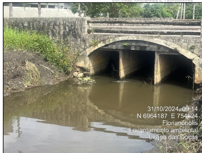
Figura 119. Saída de canal de drenagem com vazão constante de águas na parte de baixo da passagem.
