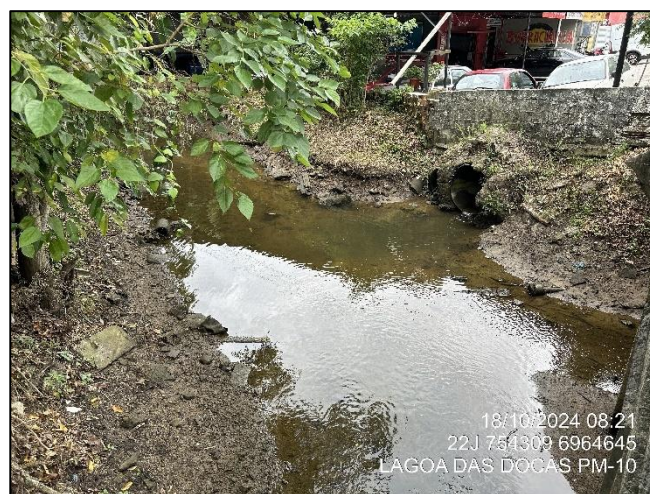
Figura 96. Canal de drenagem ou de esgotamento com deságue para o manancial.
