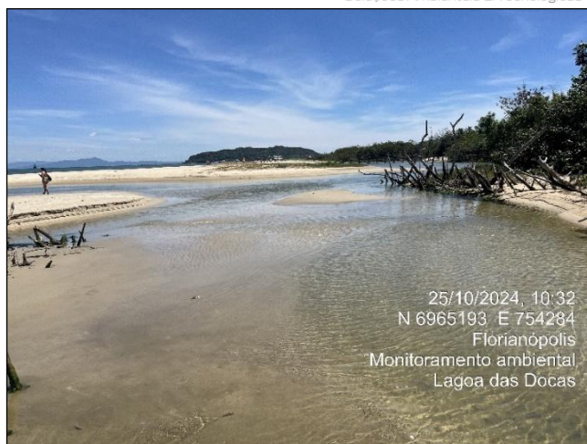
Figura 44. Deposição de sedimentos no leito do canal de escoamento.
