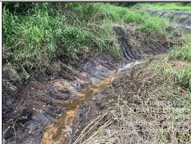
Figura 290. Escoamento das águas da nascente para o rio.
