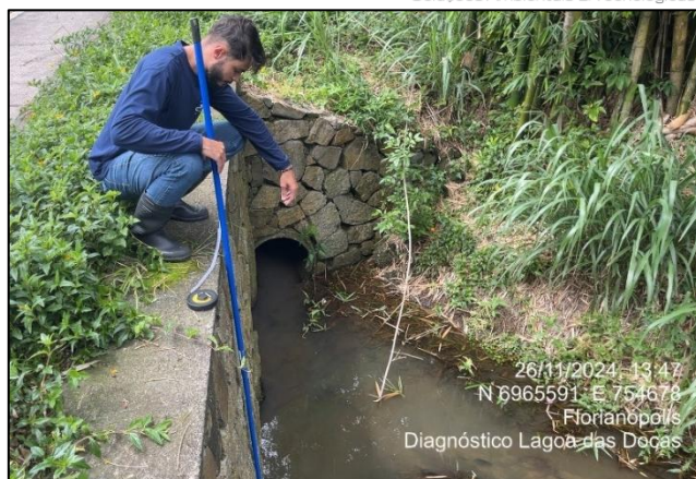
Figura 77. Medições das profundidades para elaboração do perfil batimétrico.
