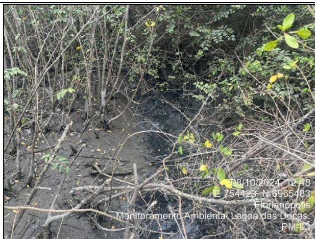
Figura 266. Em vistoria prévia realizada a tubulação de drenagem lançava águas escuras com odor característico de esgotos; ponto de observação de contaminação.
