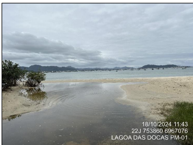
Figura 128. Estrutura de drenagem problemática sobre a área da praia com escoamento amplo, tanto para a praia quanto para a lagoa.
