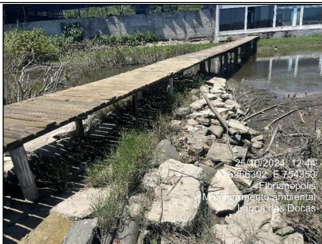
Figura 280. Restos de construção civil na área da lagoa.
