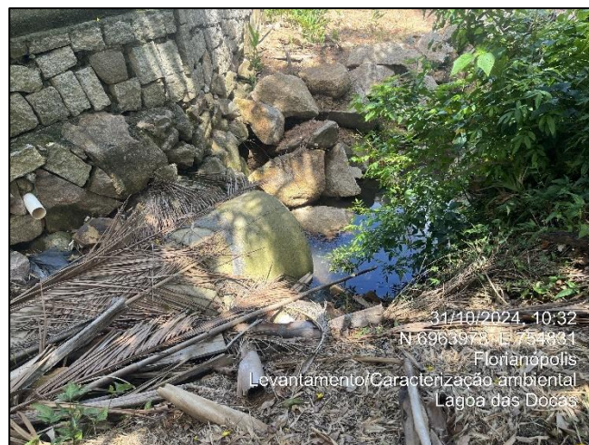
Figura 121. Canal da estrutura de drenagem/escoamento da imagem anterior.
