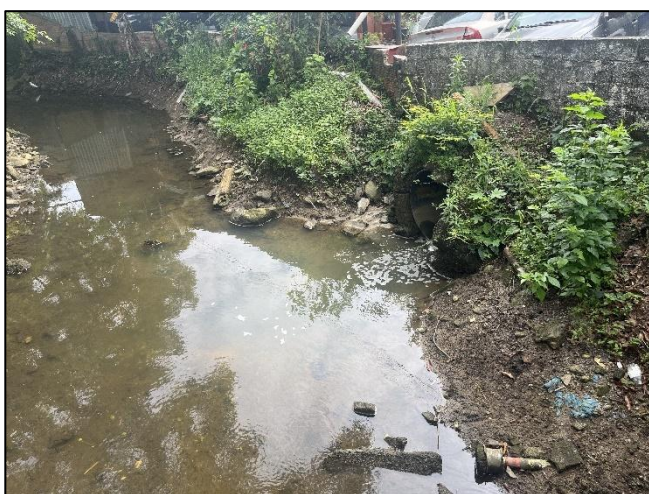
Figura 95. Canal de drenagem desembocando no rio Sanga dos bois. Observado mau cheiro e coloração escura de suas águas. Sem chuvas no momento da vistoria.
