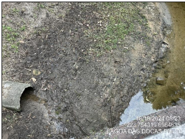
Figura 248. Canal de escoamento/drenagem localizado no leito do rio.
