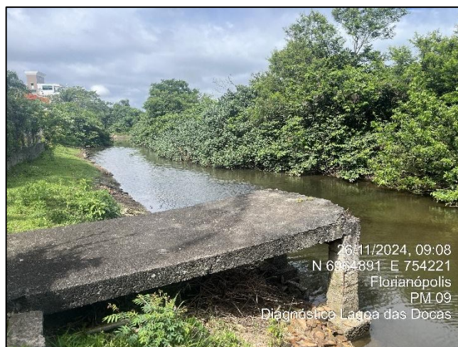
Figura 232. Detalhamento do entorno direto ao ponto do PM09
