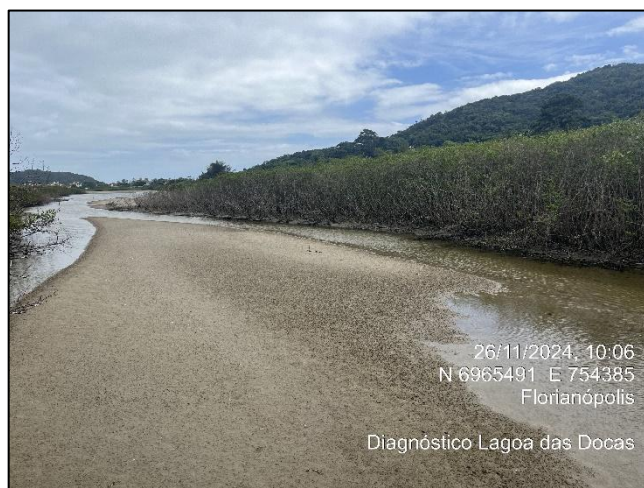
Figura 224. Detalhamento do entorno direto ao ponto do PM07.
