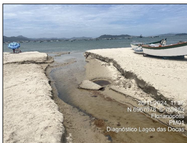
Figura 200. Detalhamento do entorno direto ao ponto da amostra de água coletada. Sistema de escoamento de água pluvial modificado no local, com realização de abertura de vala após ação antrópica.
