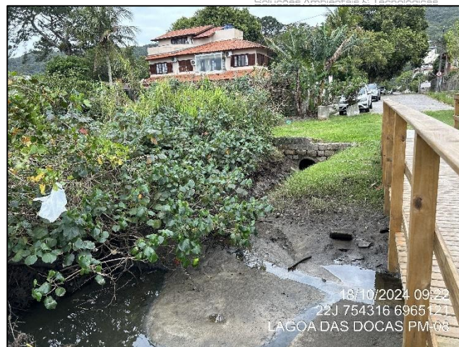
Figura 108. Estrutura de drenagem da imagem anterior.
