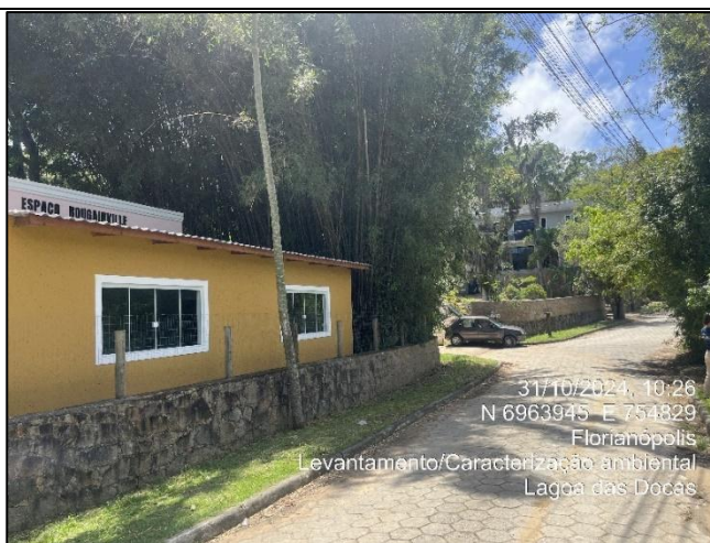
Figura 299. Espaço construído em cima do rio. Canalização sobre o manancial causando problemas na área.
