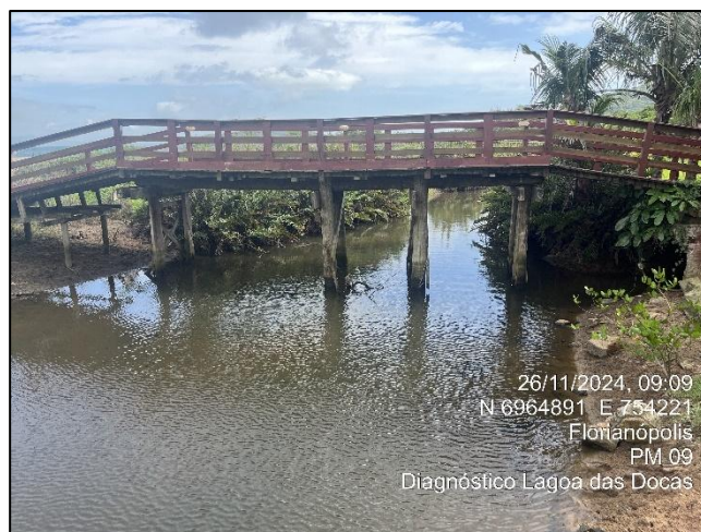
Figura 233. Detalhamento do entorno direto ao ponto do PM09
