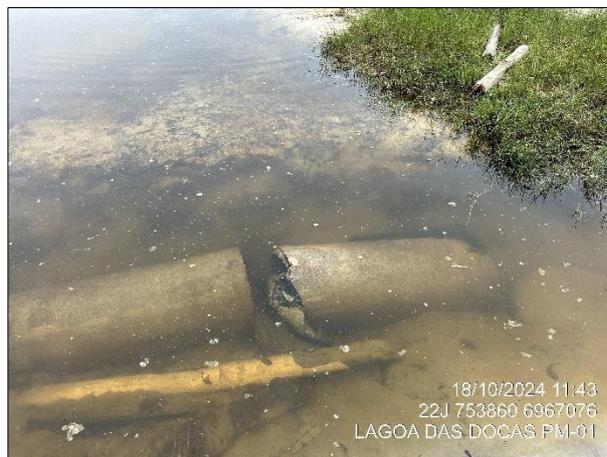
Figura 14. Registro de tubulação exposta e colapsada.
