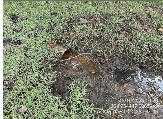
**Figura 16. Ponto de extravasamento de tubulação de drenagem pluvial ou sanitária danificada e parcialmente afogada em área de manguezal.**
