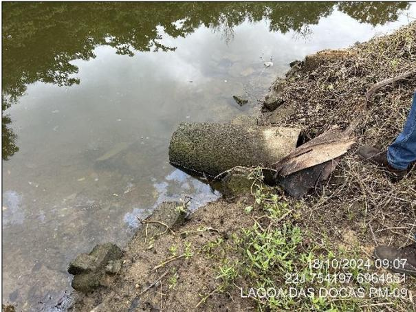
**Figura 15. Descarga de tubulação deteriorada diretamente na margem de corpo hídrico.**
