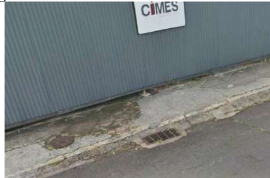
Foto 12 - Rua Machado de Assis.
