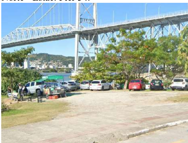
Foto 5 - Acesso à orla 5 - Av. Beira-Mar Continental.
