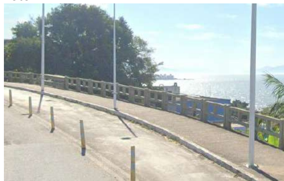
Foto 26 - Ciclovia - Viaduto Pres. Kennedy.
