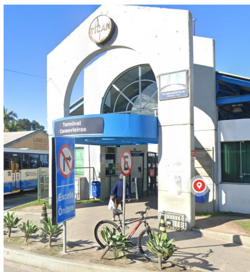
Figura 9 - Terminal de ônibus TICAN
