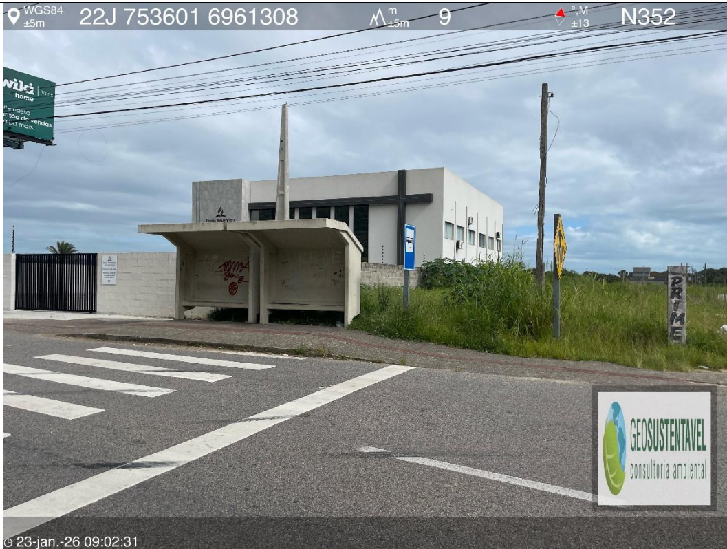
Figura 11 - Vista da parada de ônibus com cobertura sentido Leste na marginal.
