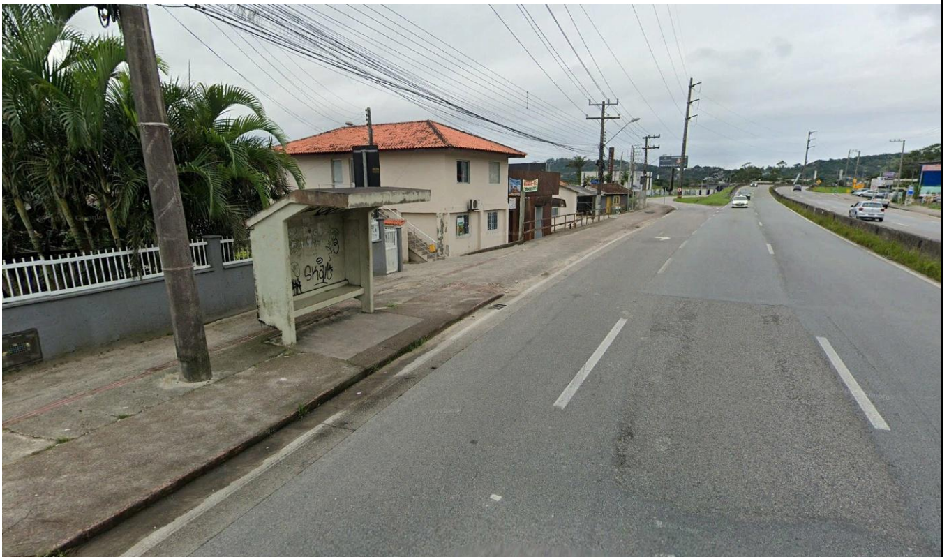
Figura 15 - Vista da parada de ônibus com cobertura sentido Oeste na marginal.
