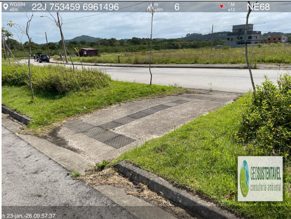
Figura 8 - Registro de rebaixo de meio-fio equipado com piso tátil de alerta e direcional localizado nas ruas do loteamento Parque Real.
