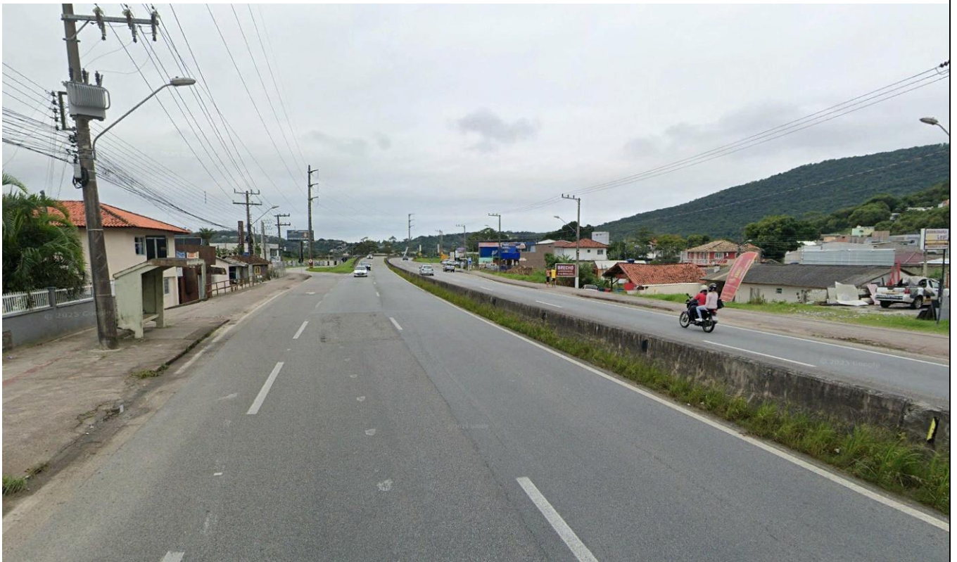
Figura 14 - Vista da parada de ônibus com cobertura sentido Oeste na marginal.
