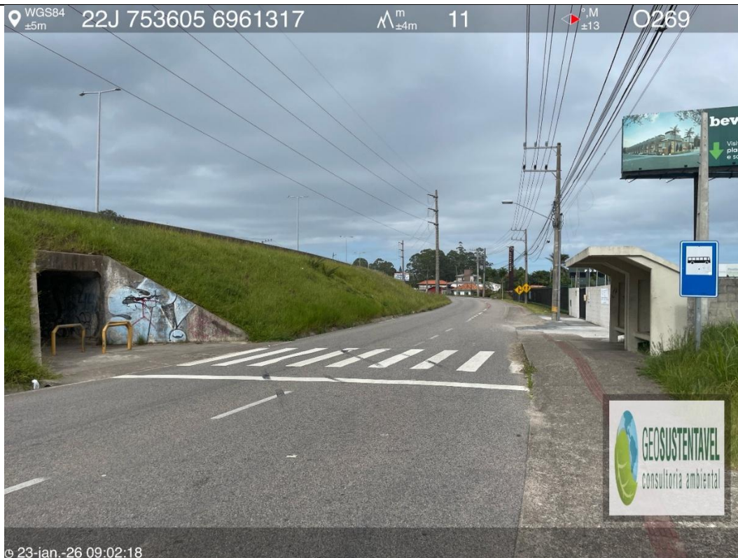
Figura 13 - Vista da parada de ônibus com cobertura sentido Leste na marginal.
