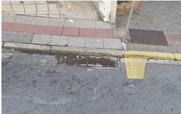
Foto 30 - Drenagem - Rua Duarte Schutel
