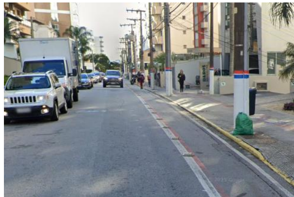
Foto 47 - Sistema Ciclovitário - Rua Duarte Schutel.
