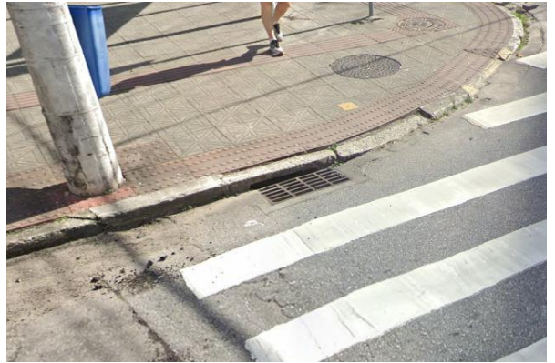
Foto 31 - Drenagem - Rua Hoepcke.
