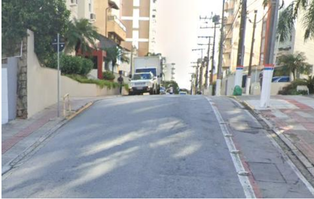
Foto 42 - Pavimentação - Rua Duarte Schutel.
