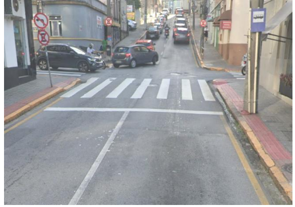
Foto 43 - Pavimentação - Rua Padre Roma.
