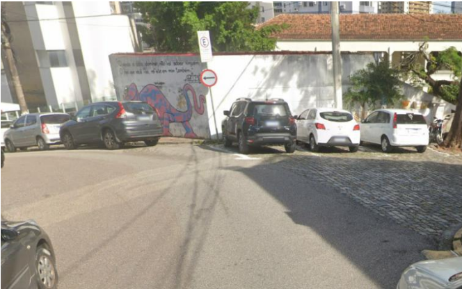
Foto 44 - Pavimentação - Rua São Francisco x Rua Padre Schuler.
