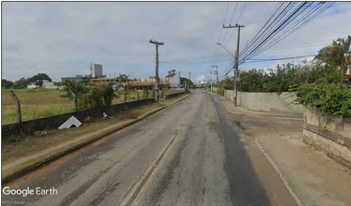
Figura 13: Av. Campeche, trecho com calçadas sem rebaixo de guias e pavimentações irregulares
