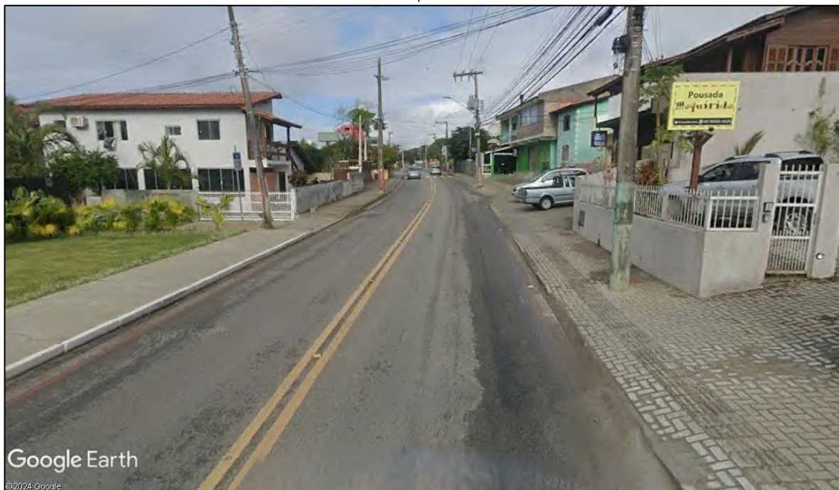
Figura 10: Av. Campeche, trecho com piso podotátil irregular, obstáculo e dimensões menores que as mínimas para o fluxo de pedestres.
