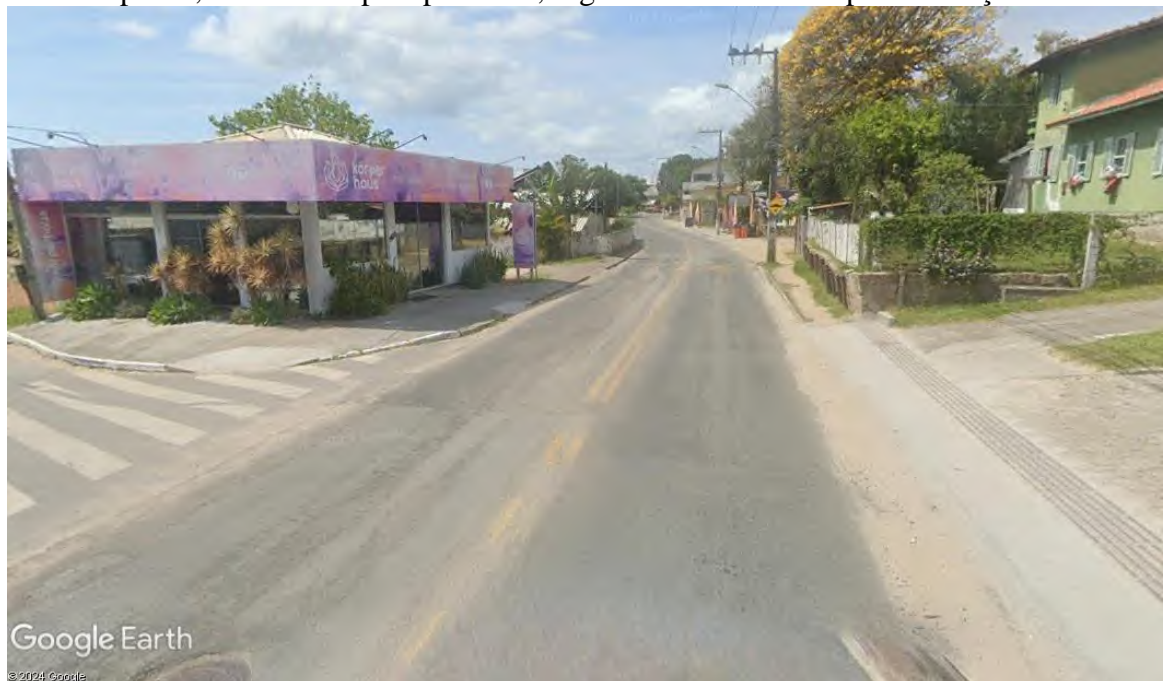
Av. Campeche, trecho com piso podotátil, seguido de trecho sem pavimentação
