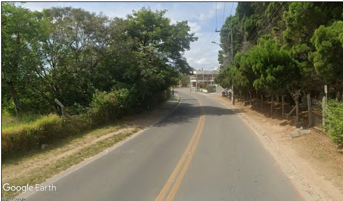
Figura 12: Av. Campeche, trecho sem pavimentação em ambos os lados da via
