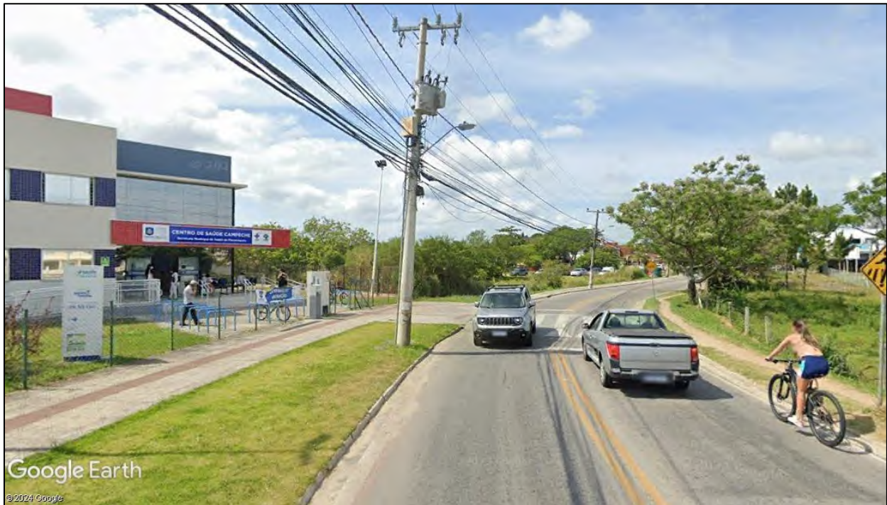
Figura 19: Rua Capela, faixa elevada
