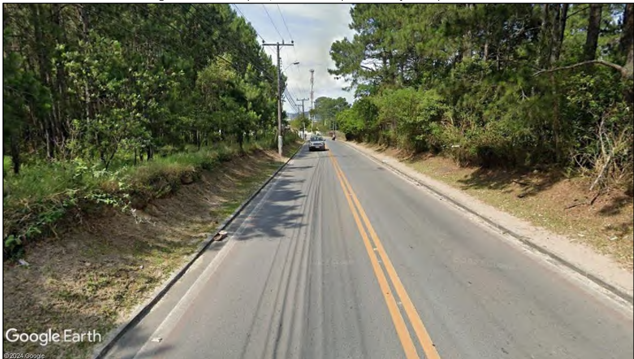
Figura 20: Rua Capela, trecho sem pavimentação de passeios
