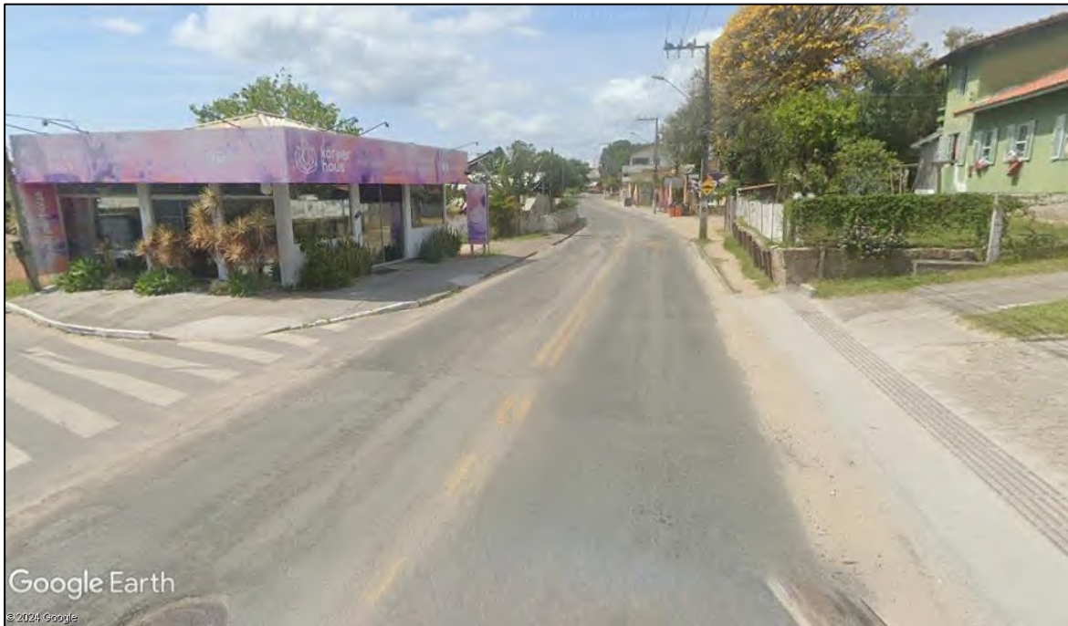
Figura 11: Av. Campeche, trecho com piso podotátil, seguido de trecho sem pavimentação
