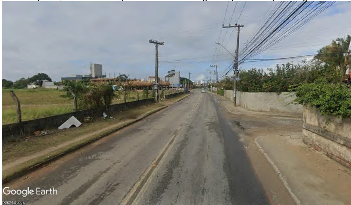
Av. Campeche, trecho com calçadas sem rebaixo de guias e pavimentações irregulares
