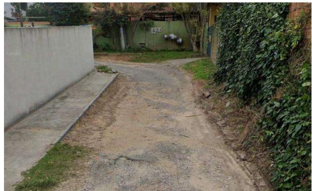
Foto 14 - Passeios inexistentes e falta de manutenção na pavimentação - Travessa da Bêncão.
