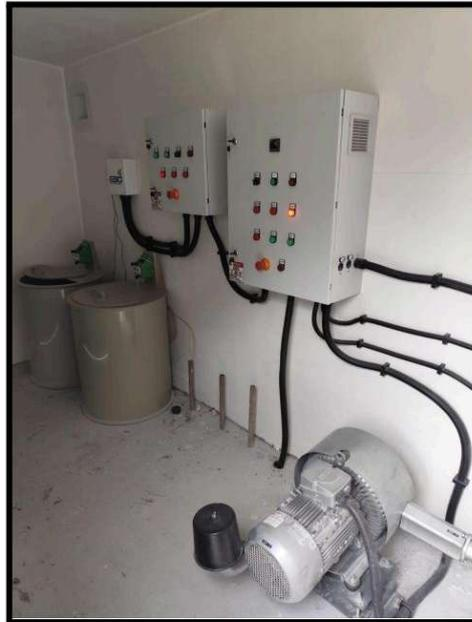
Figura 9 – Soprador de ar Radial
