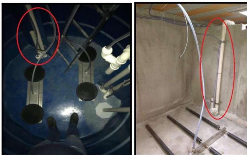
Figura 12 – Dispositivo para o retorno do lodo em vermelho
