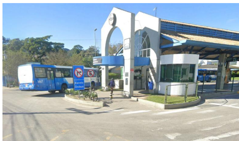
Figura 4 - Terminal de ônibus – TICAN
