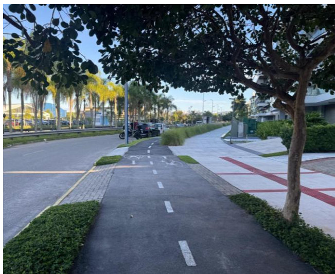
Foto 3 - Calçadas são contínuas, sem obstáculos, Av. das Lagostas.
