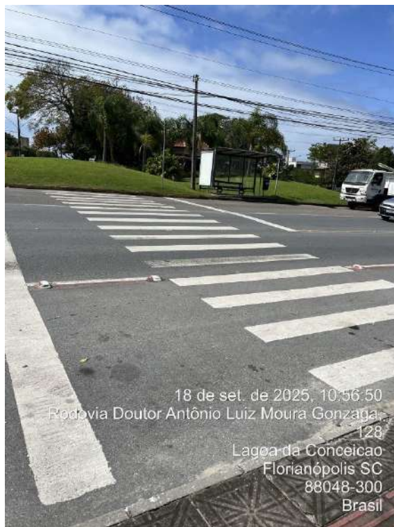
Figura 4.22- Rodovia Dr. Antônio Luiz Moura Gonzaga, com faixa sem elevação a 83m do empreendimento.
