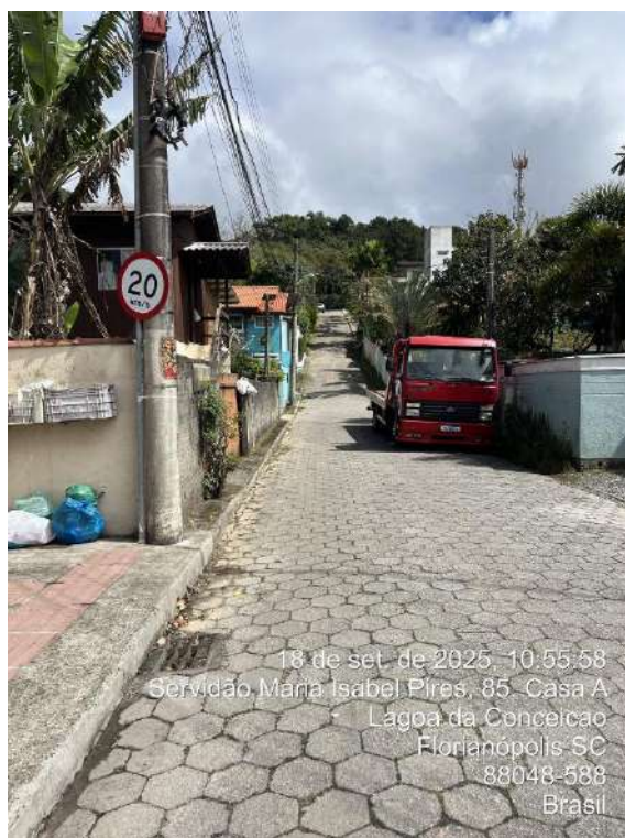
Figura 4.8 – Servidão Maria Isabel Pires (passeio sem acessibilidade).
