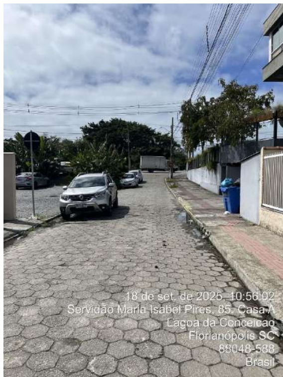
Figura 4.7 – Servidão Maria Isabel Pires (passeio com acessibilidade).
