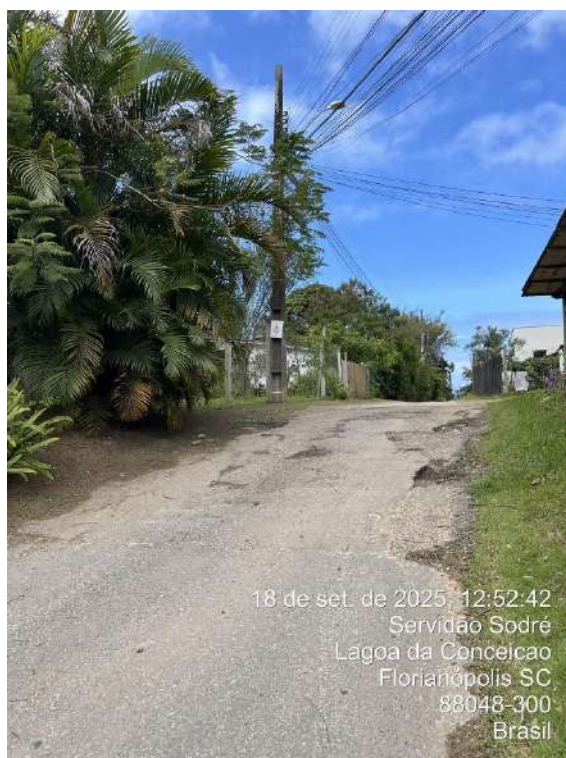
Figura 4.20 Servidão Sodre (sem passeio).
