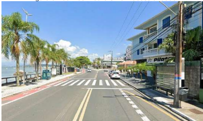
Figura 9: Rua Des. Pedro Silva – acessibilidade.
