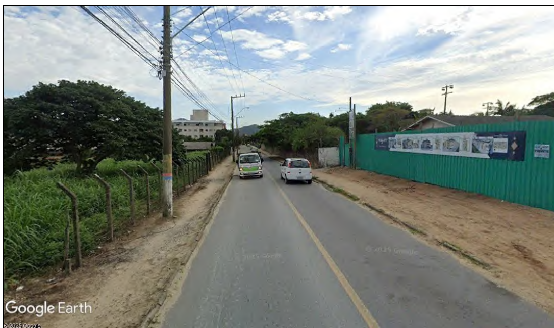
Figura 24: R. Graciliano Manoel Gomes – trecho sem pavimentação.
