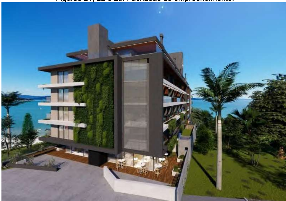
Figuras 21, 22 e 23: Fachadas do empreendimento.
