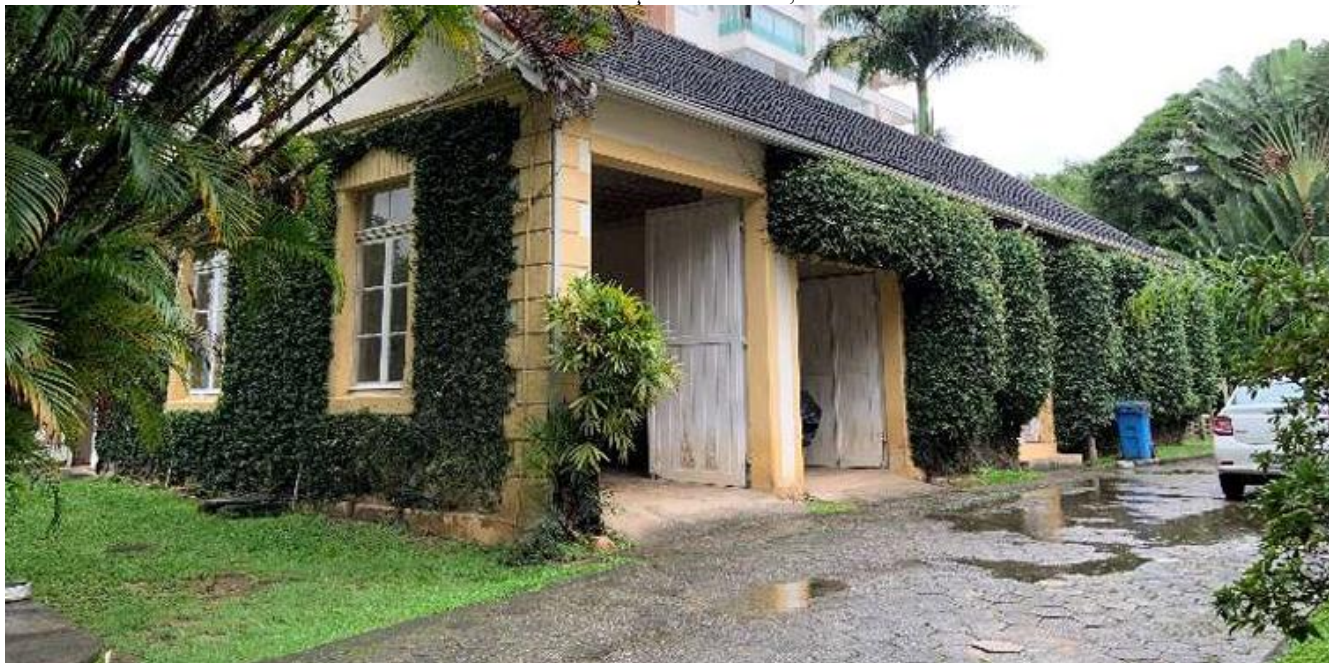
Visão entre as edificações tombadas, cenário atual
