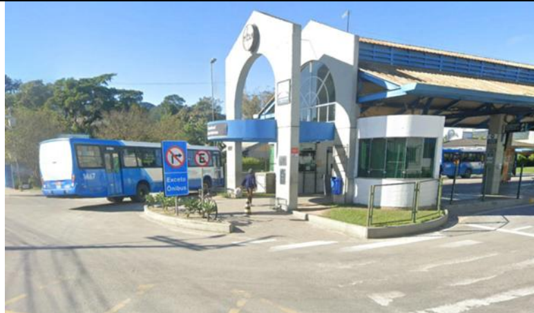
Figura 5 - Vista do acesso ao Terminal de Integração de Canasvieiras (TICAN), principal ponto de integração do transporte coletivo para os usuários provenientes do empreendimento na Avenida das Lagostas.
