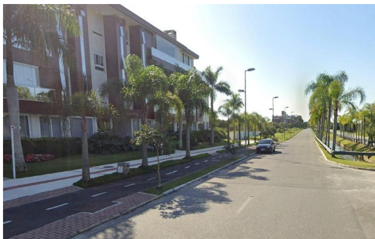
Foto 3 - Vista da Av. das Lagostas demonstrando a infraestrutura de mobilidade com ciclofaixas e calçadas implantadas em ambos os lados da via, integradas por rampas de acesso e guias rebaixadas que garantem a continuidade da rota acessível.
