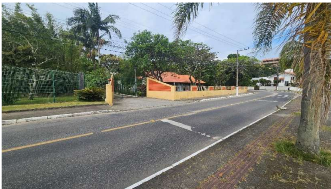
Figura 3: Portão de acesso público - comercial
