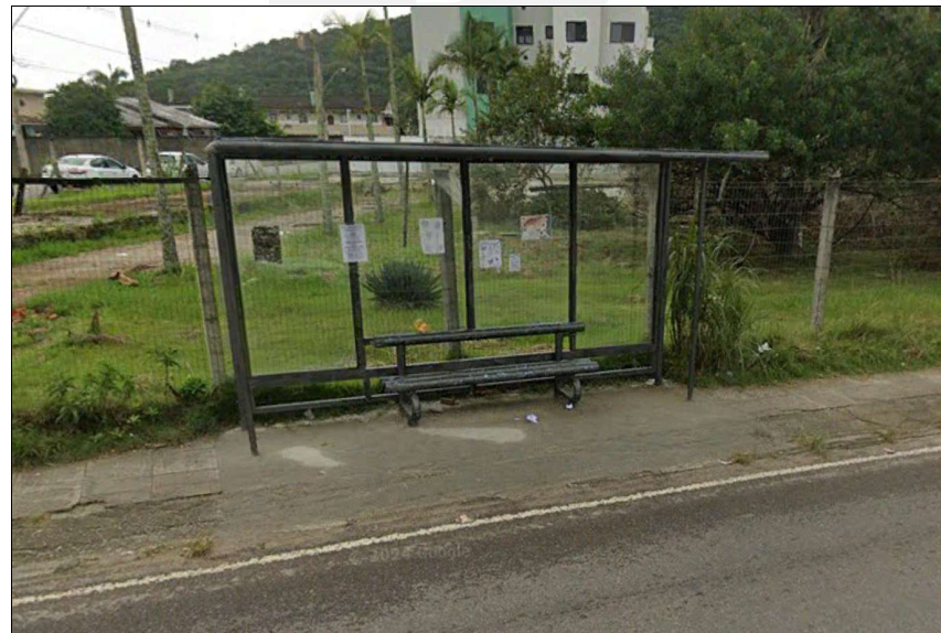
Figura 33 – Abrigo coberto para passageiros de ônibus na Estrada Cristóvão Machado de Campos
