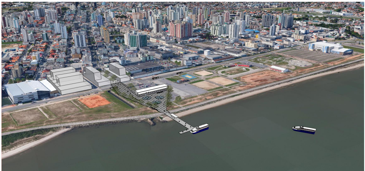
Figura 9-28 - Atracadouro São José Sul e entorno
