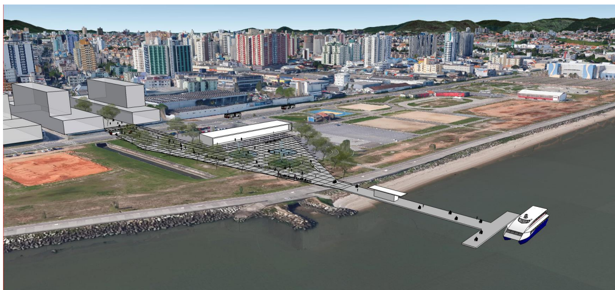
Figura 9-27 - Atracadouro São José Sul e entorno
