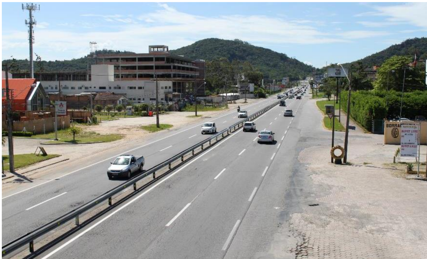
Figura 12-26: Vista atual da SC-401.
