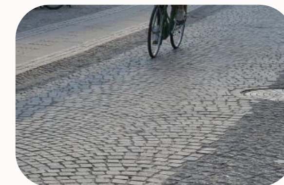
23. Superfície pavimentada confortável para andar de bicicleta: os lados da rua compartilhada são revestidos com um material polido e mais liso, que torna o ciclismo mais confortável.
