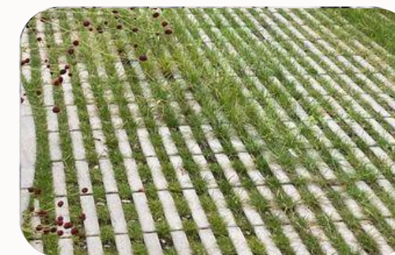
13. Pavimento permeável para parada rápida: área de embarque e desembarque com piso permeável e preenchimento verde, permitindo infiltração e suavizando o espaço.
