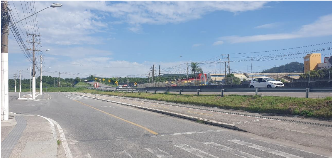
Foto 12 – Vista parcial da área de implantação do novo elevado
