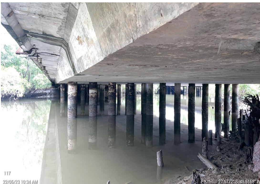
**Foto 002 - Superestrutura – Tabuleiro Estruturação dos vãos.**
