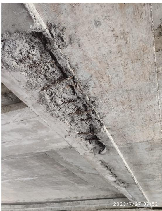
**Figura 6.10: Ponte Sertões – Junta de Concretagem**
