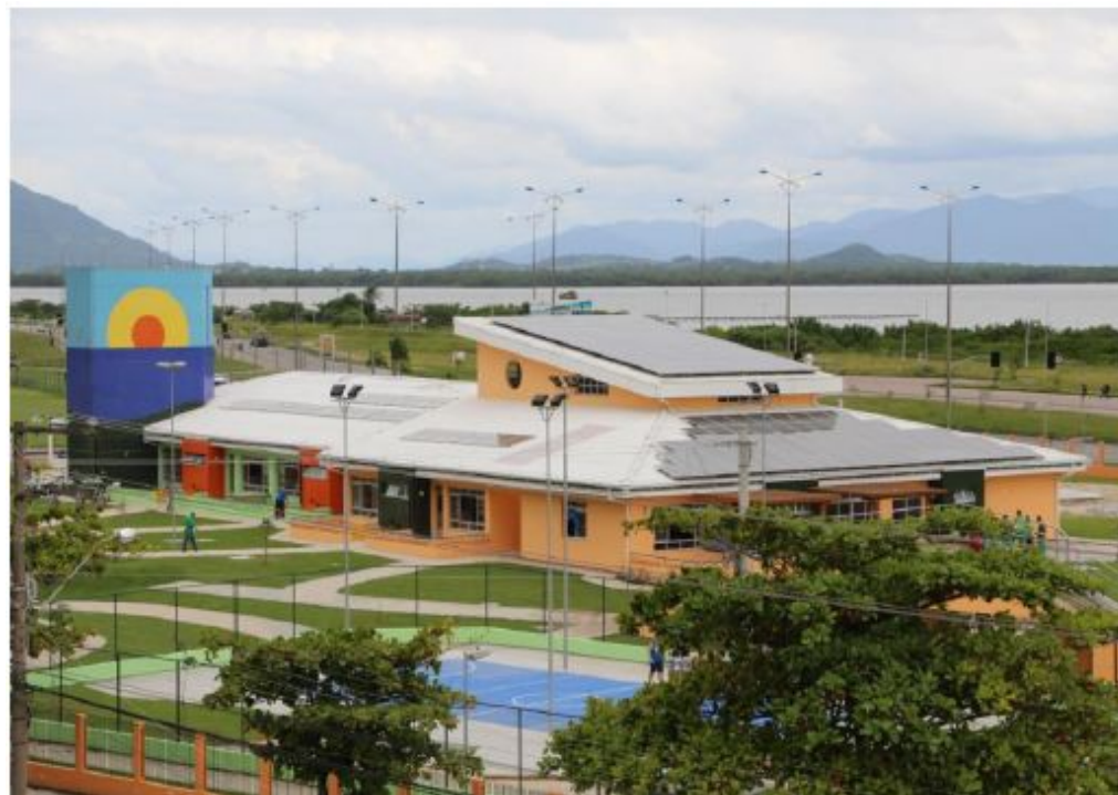
Creche Hassis. Fonte: Haus (2019).
