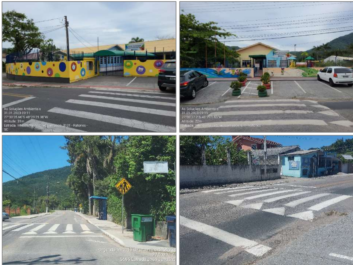
Figura 29. Condições das faixas de pedestre no entorno do empreendimento.
