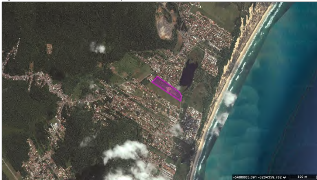
Figura 42: Contexto de entorno do empreendimento, 2015
