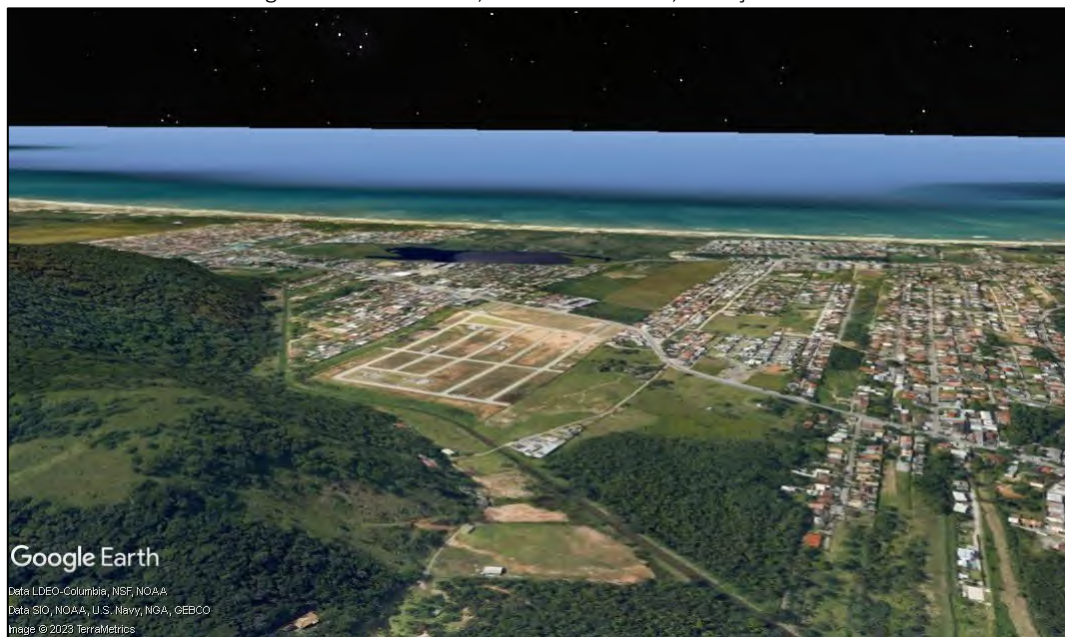
Figura 50: Vista aérea, sentido nordeste, situação atual
