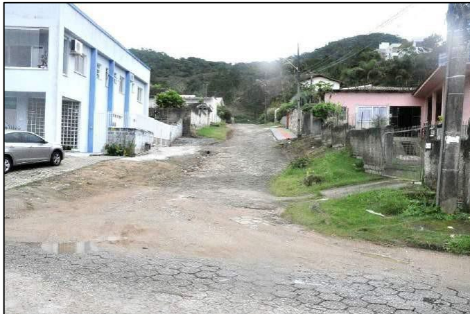
Figura 30. Servidão Alexandre Souza – Falta de passeios e pavimento em situações precárias.
