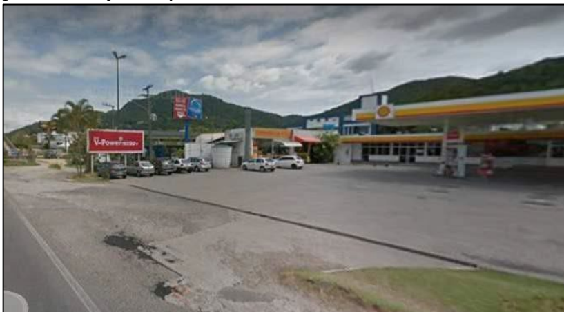
Figura 24. Serviços de Apoio – Posto de Combustíveis / Conveniência – SC 401.
