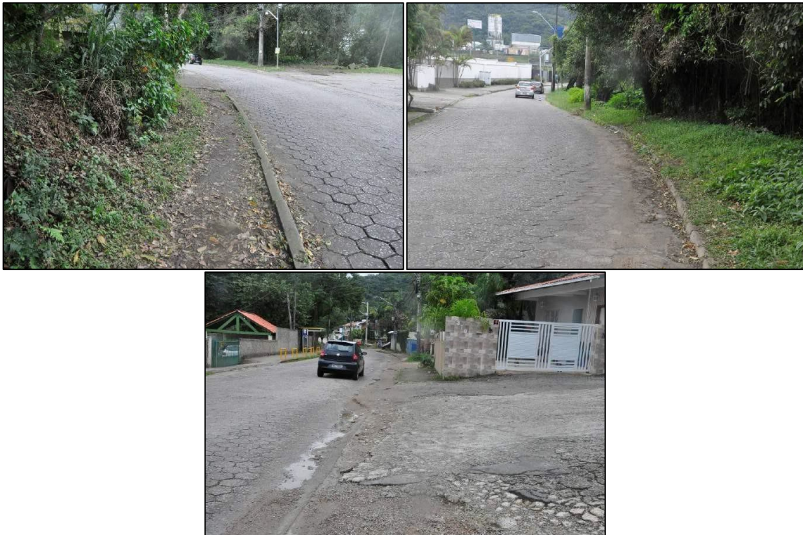
Figura 27. Estrada Antônio Soares Glavan – Detalhe da rede de energia /Iluminação Pública /Falta de passeios pavimentados.
