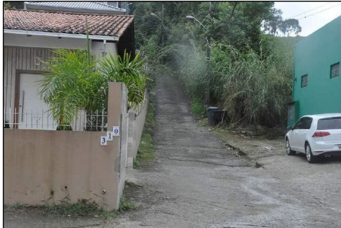
Figura 26. Servidão Valmir Leônida – Falta de passeios e pavimento em situações precárias.
