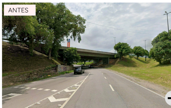
Imagem de transposição existente. Fonte: Google Earth
