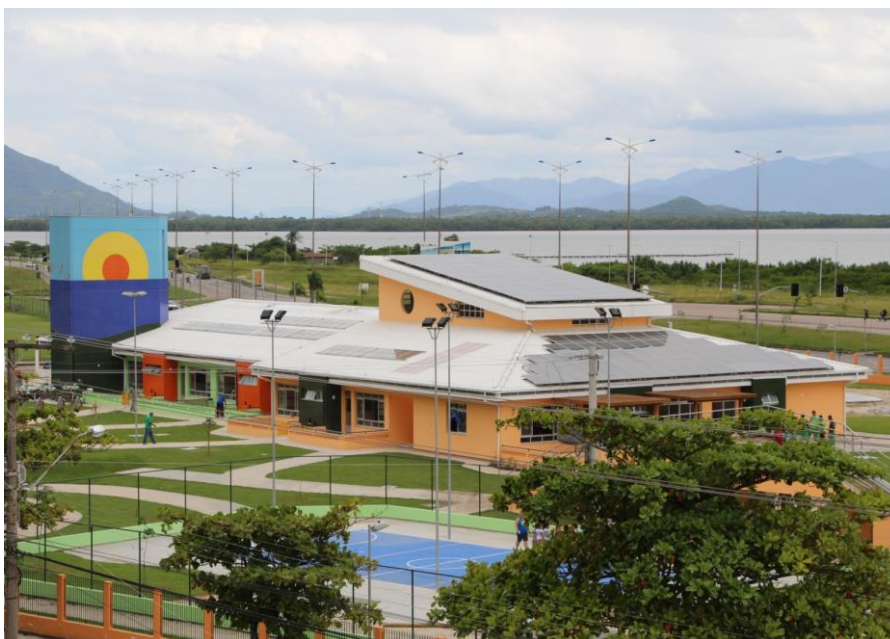
Figura 1 – Creche Hassis – Autossuficiente em energia
