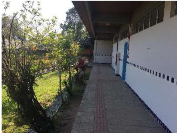
(c) Detalhe para corredores abertos e janelas basculantes para as salas de aula.
