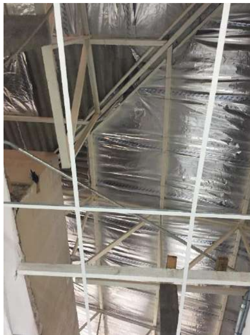
(b) Detalhe para barreira radiante na cobertura
