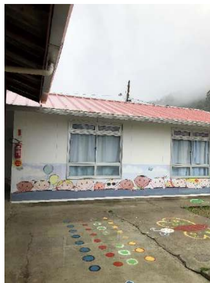
(b) Sala de aula vista de fora
