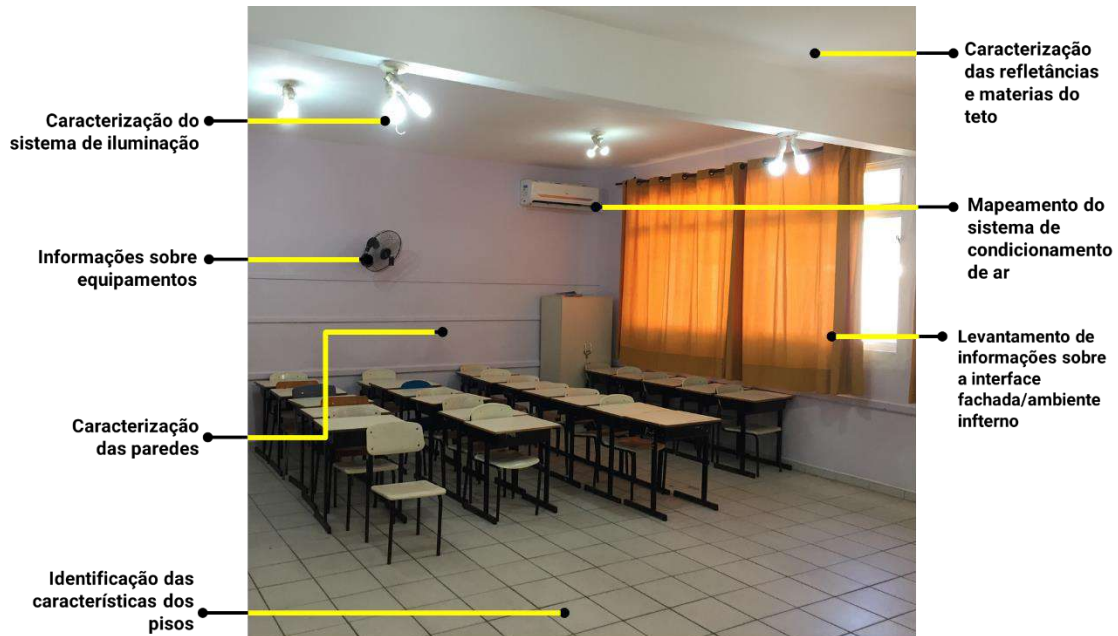
Figura 2 – Identificação das características da edificação durante visita ao local.
