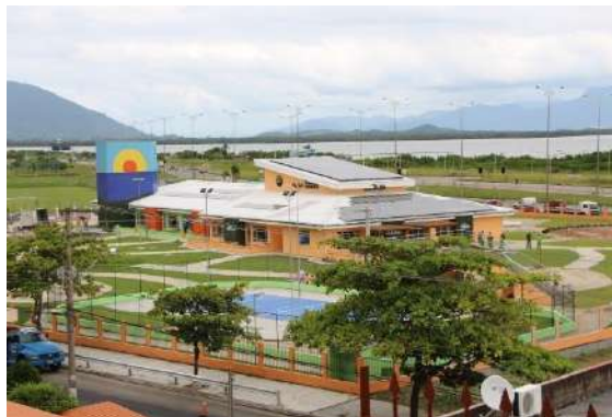
(a) Visão geral da edificação
