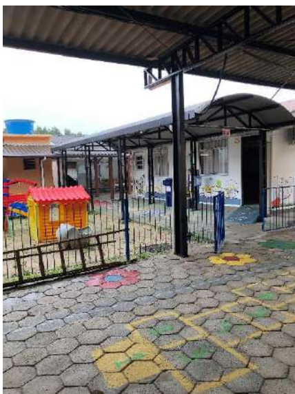
(a) Visão geral externa do pátio e das salas de aula
