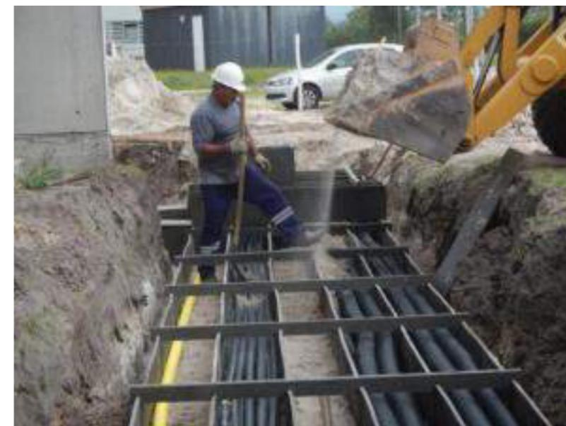
Figura 22: facilidade de execução de infra modular. Fonte: Infracities.
