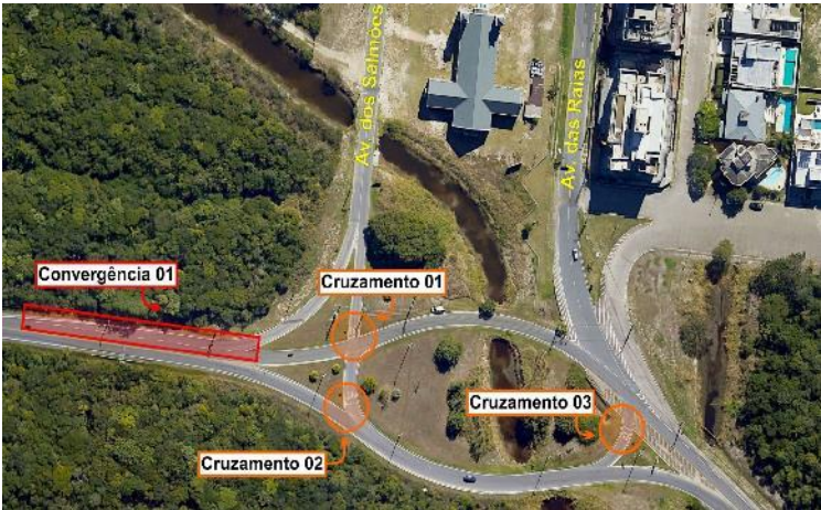
Figura 16: interseção no entroncamento entre a SC-400 e a Av. das Raias e Av. dos Salmões
