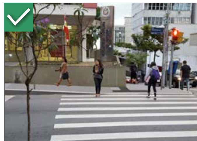
Rebaixamento total da esquina com i < 5\% , proporcionando caminhar mais fluido.
