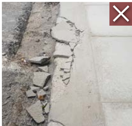
Meio-fio preenchido com argamassa e placas e com pintura branca decorativa.
