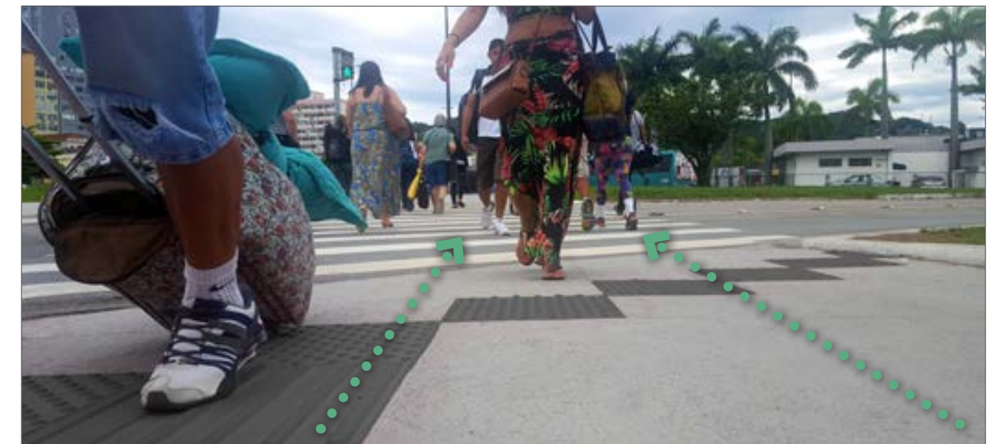
Piso tátil adequado ao sentido de atravessamento
