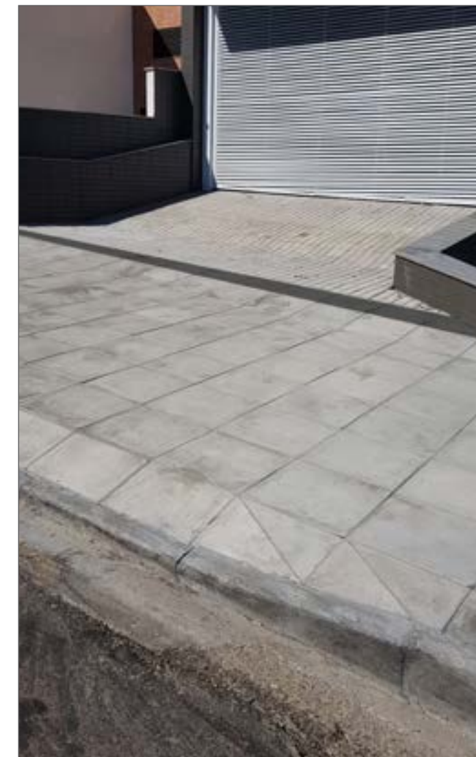
Se o meio-fio tiver 15cm de altura, a rampa para acesso à garagem terá comprimento de 22,5cm, equivalente a meia placa cimentícia padrão.
