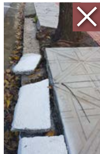
Meio-fio preenchido com argamassa e placas e com pintura branca decorativa.
