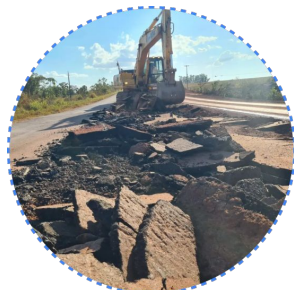
REMOÇÃO DA PAVIMENTAÇÃO
