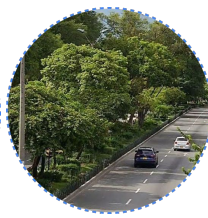
ABERTURA DE CANTEIROS E ARBORIZAÇÃO
