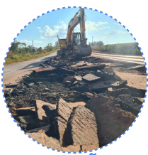
REMOÇÃO DA PAVIMENTAÇÃO
