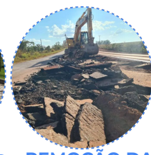
REMOÇÃO DA PAVIMENTAÇÃO
