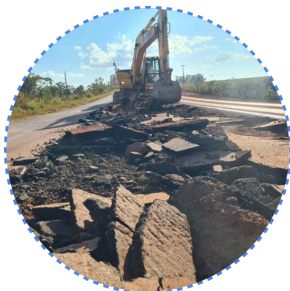
REMOÇÃO DA PAVIMENTAÇÃO
