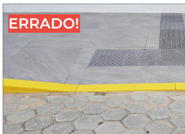
Figura 124: Exemplo de meio-fio inadequado, com pintura aplicada no meio-fio em vez da pista.
