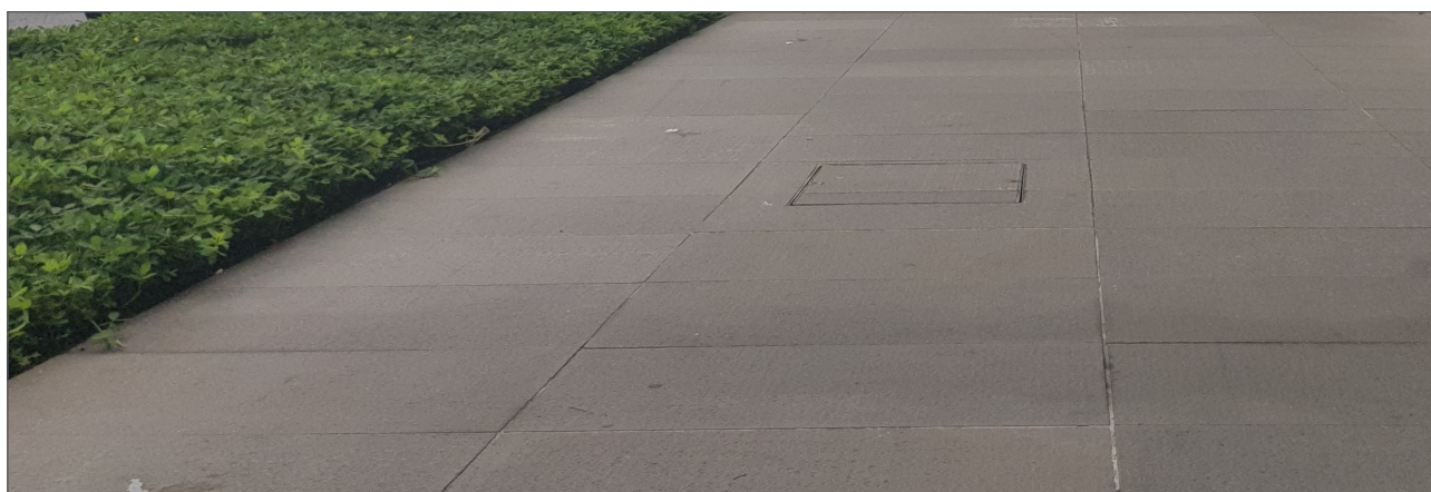
Figura 115: Pavimentação em basalto, com placas em acabamento escovado ou flameado, que apresenta baixa porosidade e bom desempenho em áreas expostas à maresia.
