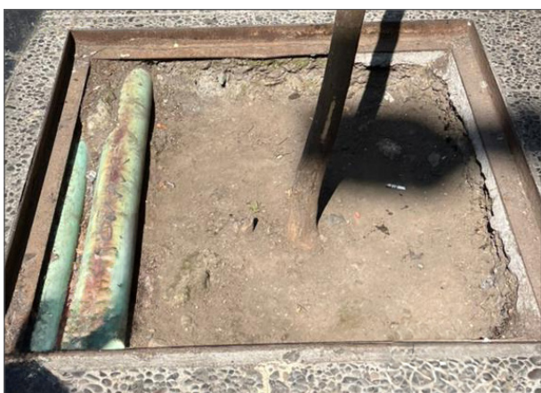
Figura 137: As tubulações e fiações devem ser posicionadas de forma a não impedir a arborização.
