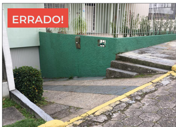
Figura 25: Rampas posicionadas incorretamente ocupando a faixa livre da calçada e impedindo a passagem.
