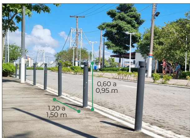
Figura 67: Balizadores do tipo pilarete, utilizados para o bloqueio de veículos, garantindo a segurança de pedestres.
