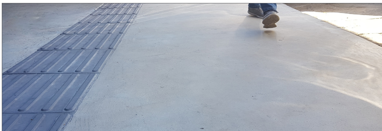
Figura 113: Calçada executada em concreto armado moldado in loco, com superfície antiderrapante, contínua e regular, adequada para garantir conforto e segurança na circulação de pedestres.
