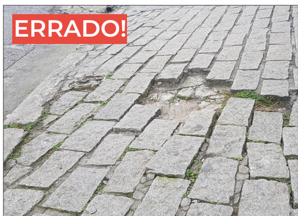
Figura 120: Paralelepípedo não deve ser utilizado em calçadas por ser trepidante.
