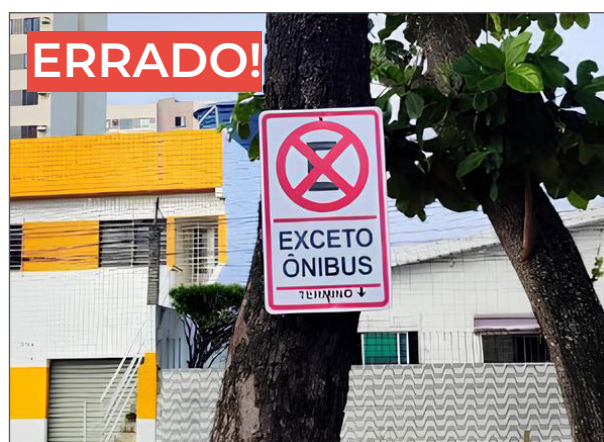
Figura 138: Não é permitida a instalação de placas nos troncos das árvores.
