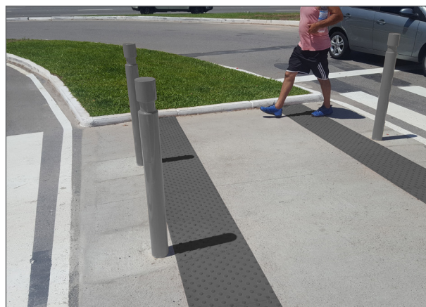
Figura 70: É recomendado o uso de balizadores em cinza com altura de 0,60 m a 0,95 m.
