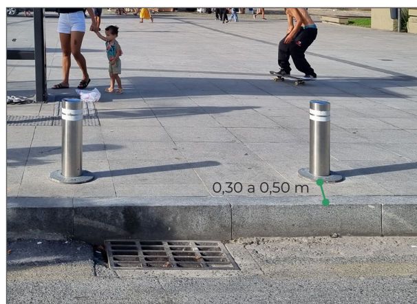
Figura 68: Balizadores do tipo pilarete, utilizados para o bloqueio de veículos, garantindo a segurança de pedestres.
