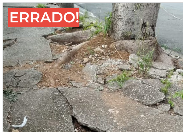
Figura 131: A utilização de espécies inadequadas pode ocasionar o rompimento da calçada.
