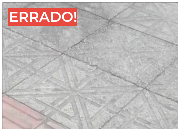
Figura 119: Pisos com textura vazada comprometem a percepção do piso tátil.
