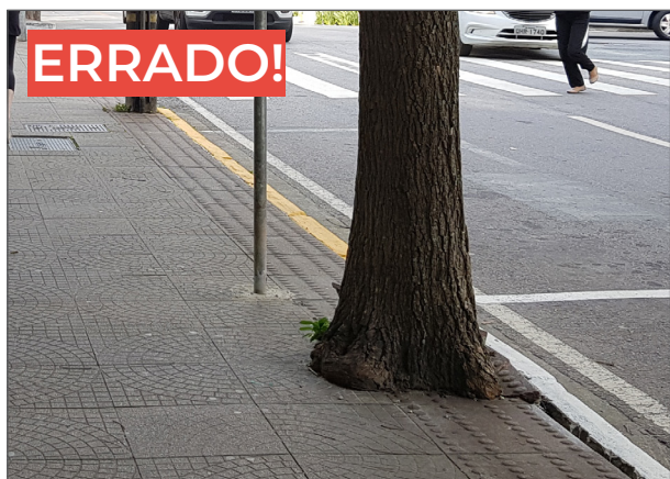
Figura 130: Calçada sem espaço adequado para canteiros arborizados, resultando no sufocamento das raízes.
