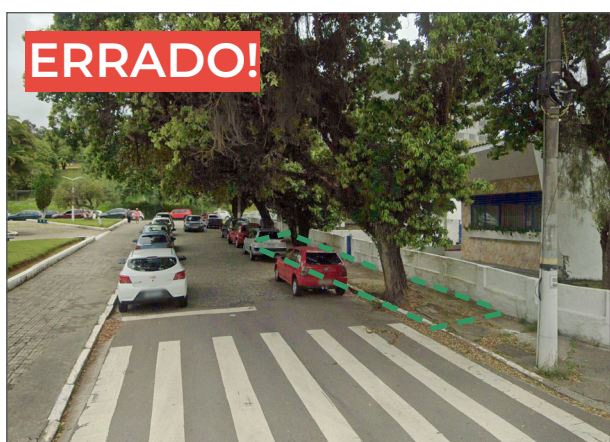
Figura 132: Calçada sem espaço adequado para canteiros arborizados, com danos para as árvores e calçada.
