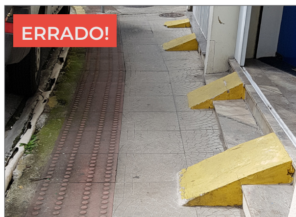
Figura 26: Rampas posicionadas incorretamente ocupando a faixa livre da calçada e impedindo a passagem.
