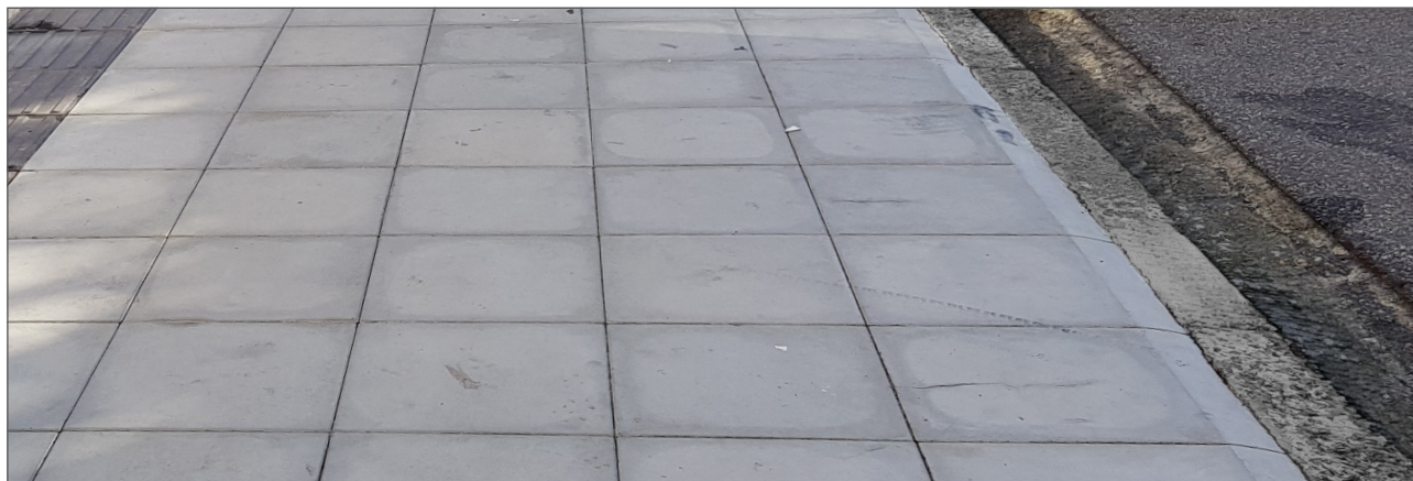
Figura 112: O piso de placa cimentícia lisa deve ser antiderrapante e instalado com juntas estreitas. O meio-fio deve ser mantido sem qualquer pintura ou revestimento.
