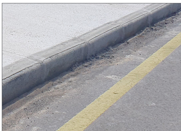
Figura 123: Meio-fio nivelado com o restante da calçada, sem revestimentos e com a pintura realizada na pista.
