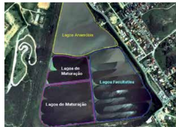
Figura 8.4: Estação de Tratamento de Esgotos Sanitários de Potecas (SESFC)
