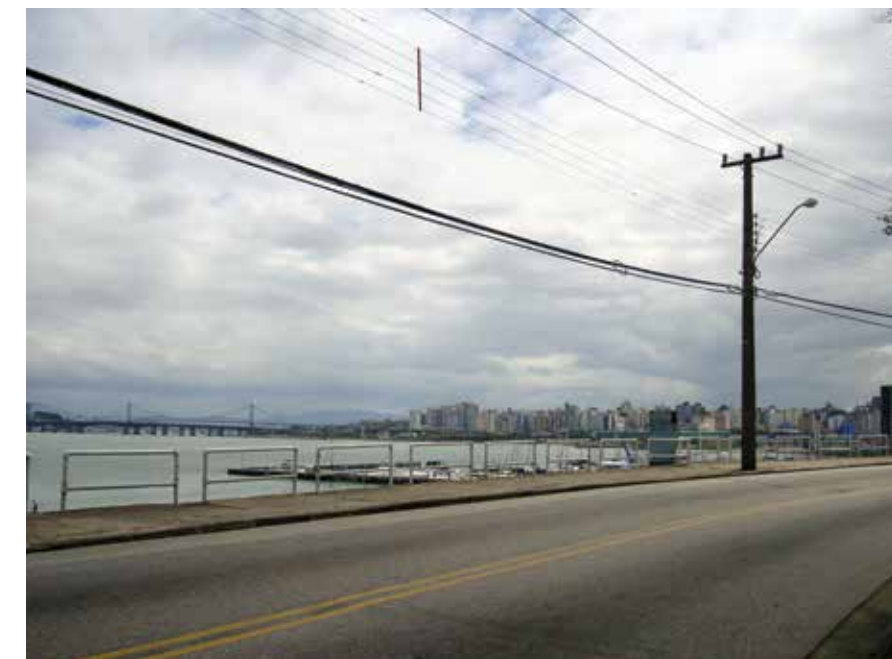
Figura 8.24: Rede elétrica aérea
