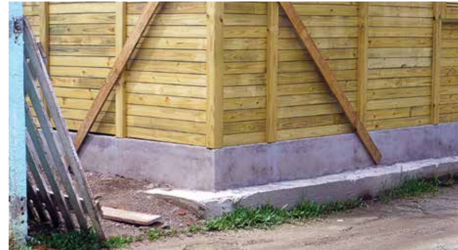
Figura 5.11: Exemplo de uma construção adaptada, localizada em zona inundável no bairro Praia dos Ingleses
