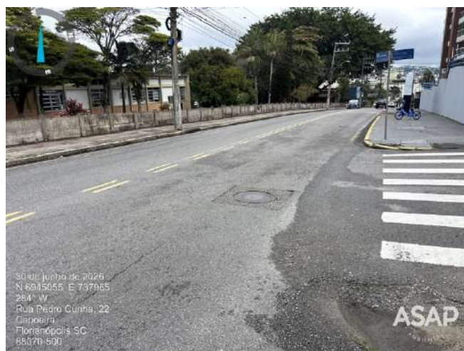
Foto 5.6. Pavimentação asfáltica na Rua Santos Saraiva, esquina com Rua Pedro Cunha. Fonte: ASAP, 2026.
