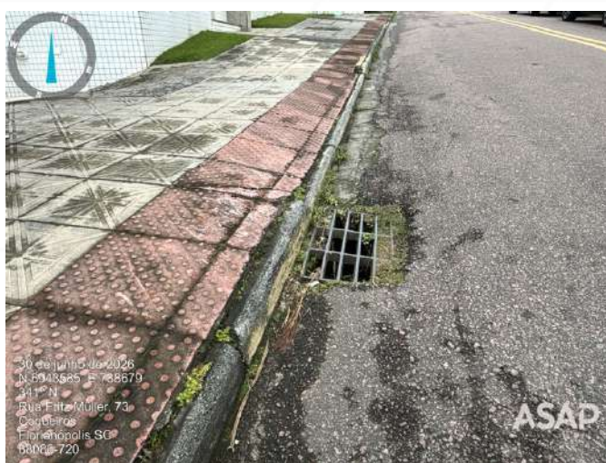
Foto 4.17. Bueiro em bom estado na Rua Fritz Muller. Fonte: ASAP, 2026.
