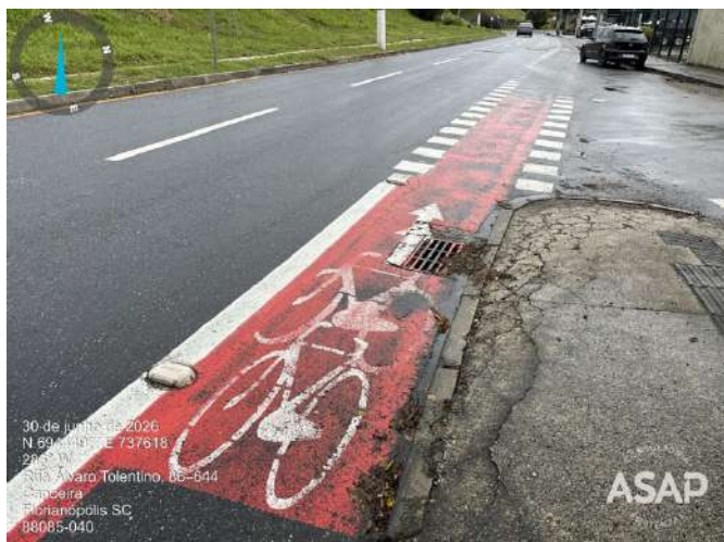
Foto 4.1. Bueiro em bom estado junto à Rua Álvaro Tolentino. Fonte: ASAP.
