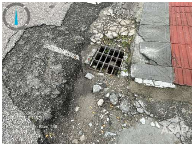
Foto 4.13. Bueiro verificado e registrado junto à Rua Doutor Heitor Blum. Fonte: ASAP, 2026.
