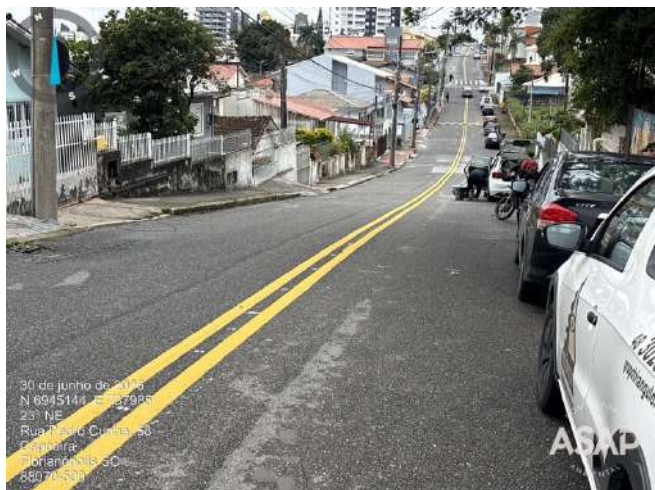
Foto 5.7. Pavimentação asfáltica na Rua Pedro Cunha. Fonte: ASAP, 2026.
