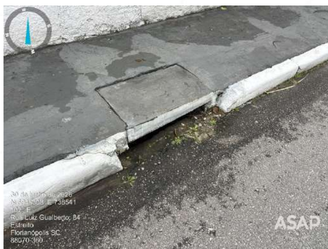
Foto 4.11. Bueiro em bom estado na Rua Luiz Gualberto. Fonte: ASAP, 2026.
