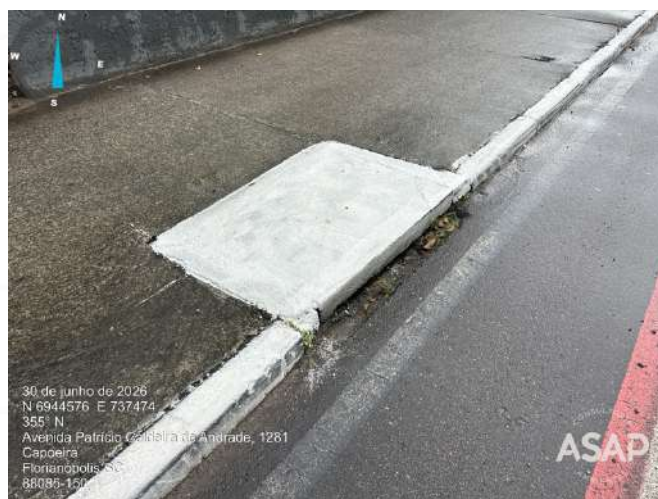
Foto 4.2. Bueiro em bom estado -Av. Patricio Caldeira de Andrade.
