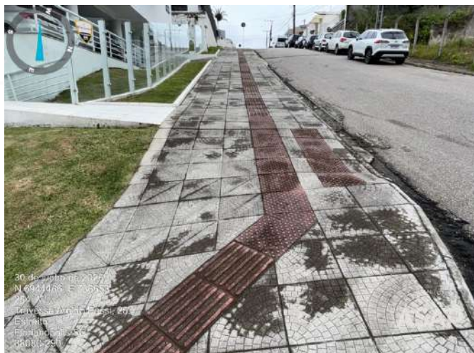
Foto 1.25. Trecho de passeio com acessibilidade observado junto à Travessa Aroldo Pessi. Fonte: ASAP, 2026.
