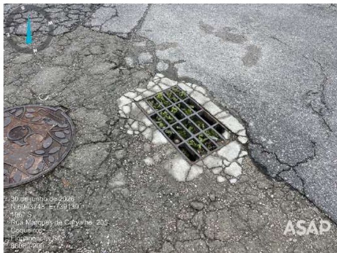
Foto 4.19. Bueiro em bom estado na Rua Marques de Carvalho. Fonte: ASAP, 2026.
