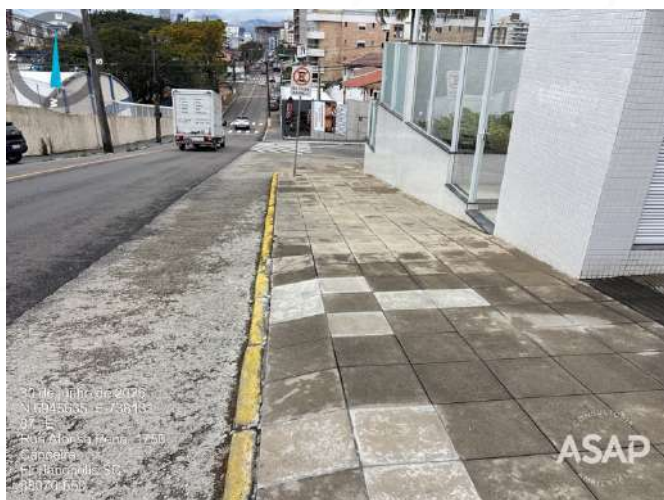
Foto 1.11. Trecho de passeio acessível verificado entre as ruas Joaquim Nabuco e Afonso Pena. Fonte: ASAP, 2026.
