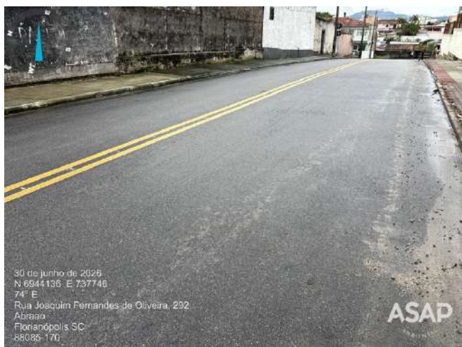
Foto 5.3. Pavimentação asfáltica na Rua Joaquim Fernandes de Oliveira. Fonte: ASAP, 2026.
