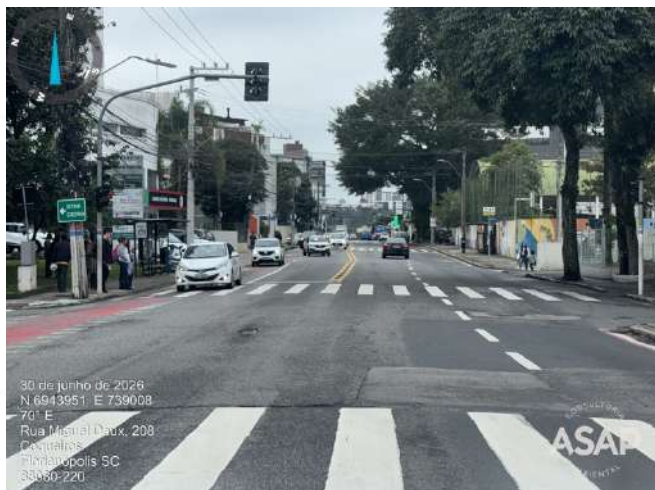
Foto 5.19. Pavimentação na Avenida Engenheiro Max de Souza. Fonte: ASAP, 2026.
