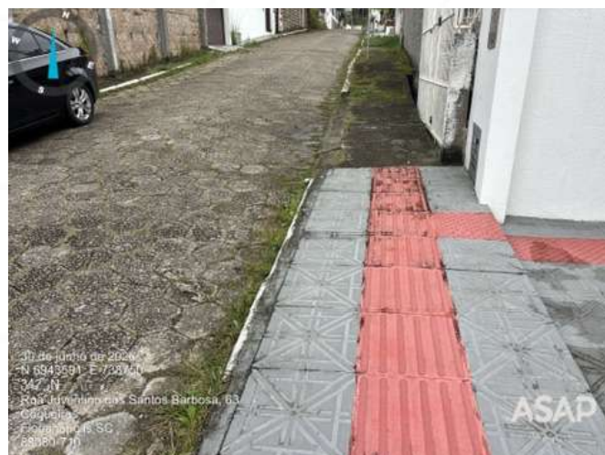
Foto 1.18. Trecho de passeio sem acessibilidade observado junto à Rua Juventino dos Santos Barbosa. Fonte: ASAP, 2026.
