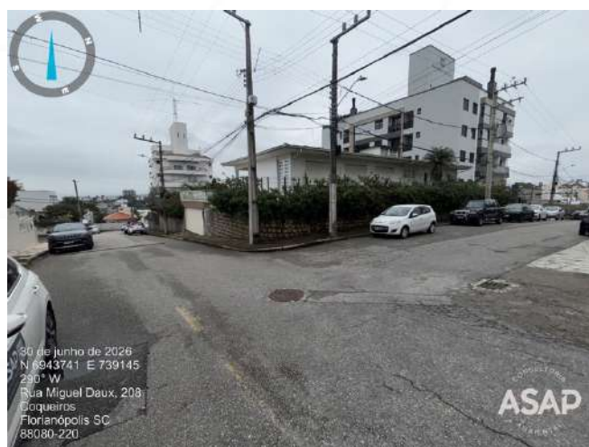
Foto 5.18. Pavimentação na Rua Miguel Daux. Fonte: ASAP, 2026.
