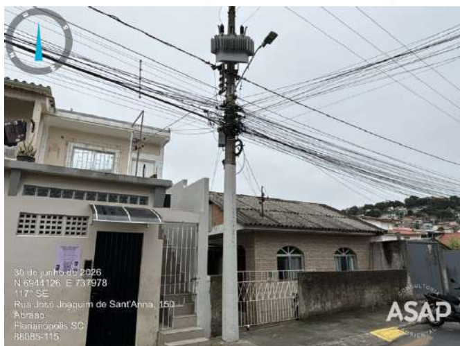
Foto 3.5. Iluminação em LED na R. José Joaquim de Santana. Fonte: ASAP.
