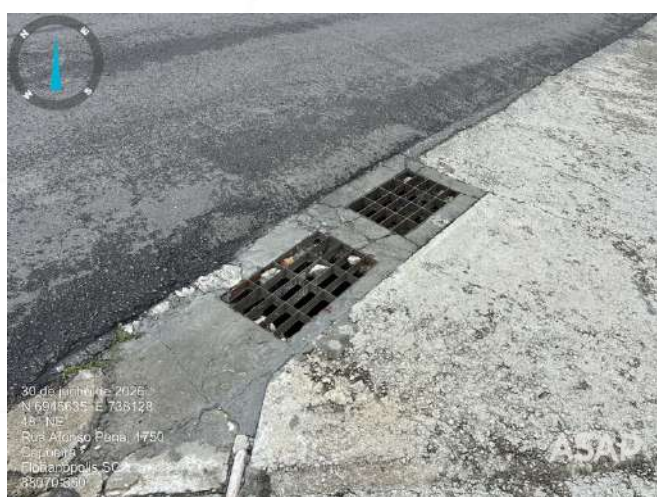
Foto 4.9. Bueiros em bom estado na Rua Afonso Pena. Fonte: ASAP, 2026.
