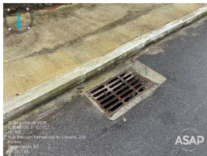
Foto 4.4. Bueiro em bom estado. Fonte: ASAP, 2026.
