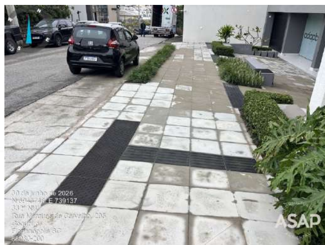
Foto 1.22. Trecho de passeio com acessibilidade observado junto à Rua Marques de Carvalho. Fonte: ASAP, 2026.
