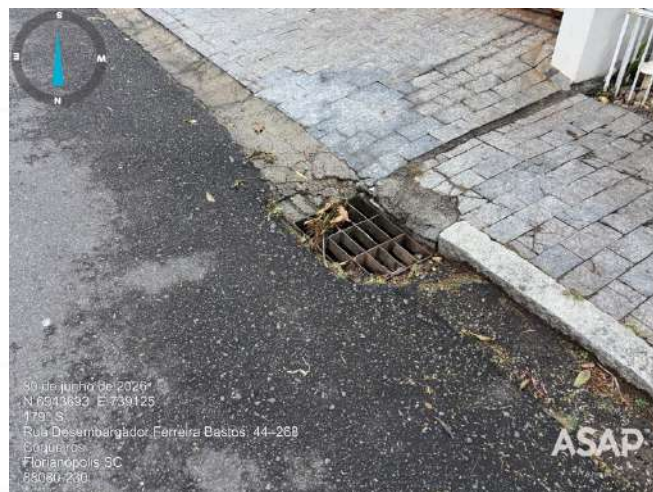
Foto 4.20. Bueiro em bom estado na Rua Desembargador Ferreira Bastos. Fonte: ASAP, 2026.
