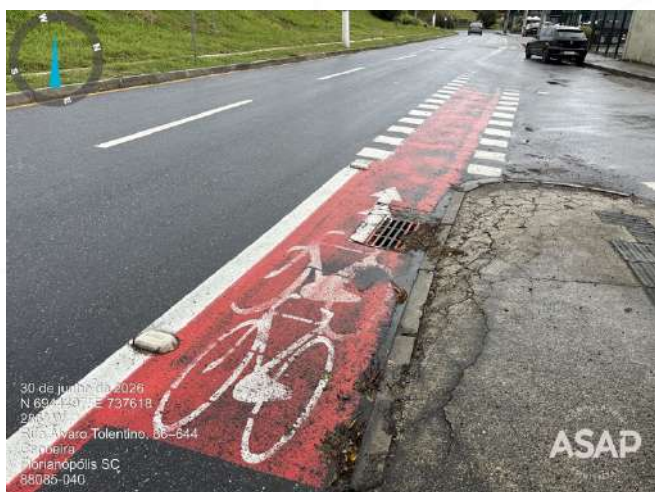
Foto 5.1. Pavimentação asfáltica na Rua Álvaro Tolentino. Fonte: ASAP, 2026.
