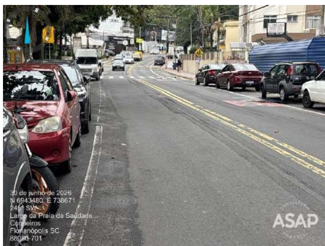
Foto 5.15. Pavimentação na Rua Des. Pedro Silva. Fonte: ASAP, 2026.
