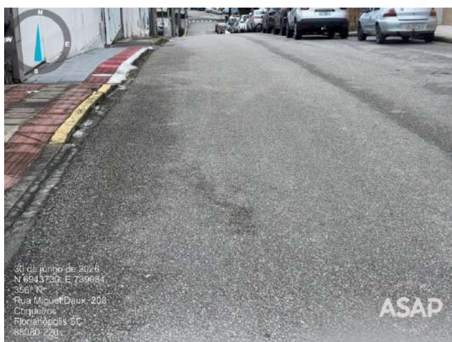
Foto 5.17. Pavimentação na Rua Miguel Daux. Fonte: ASAP, 2026.
