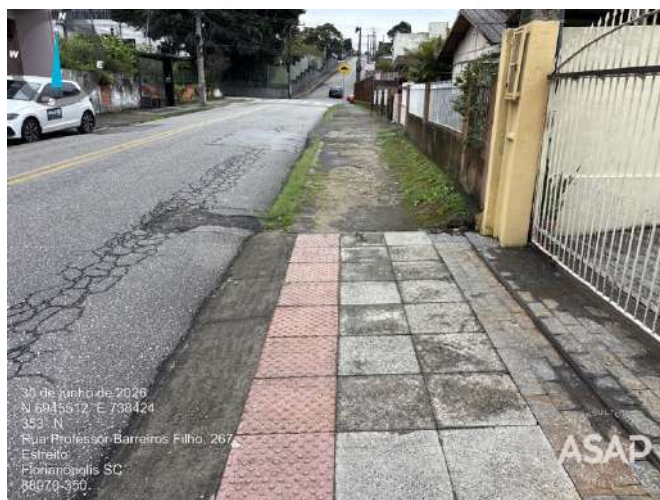
Foto 1.12. Trecho de passeio mal conservado observado junto à Rua Professor Barreiros Filho. Fonte: ASAP, 2026.
