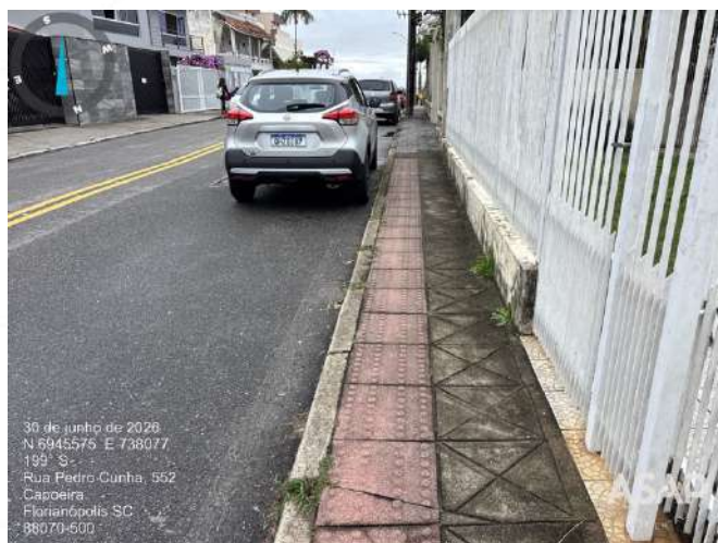
Foto 1.10. Trecho de passeio acessível verificado na Rua Pedro Cunha. Fonte: ASAP, 2026.
