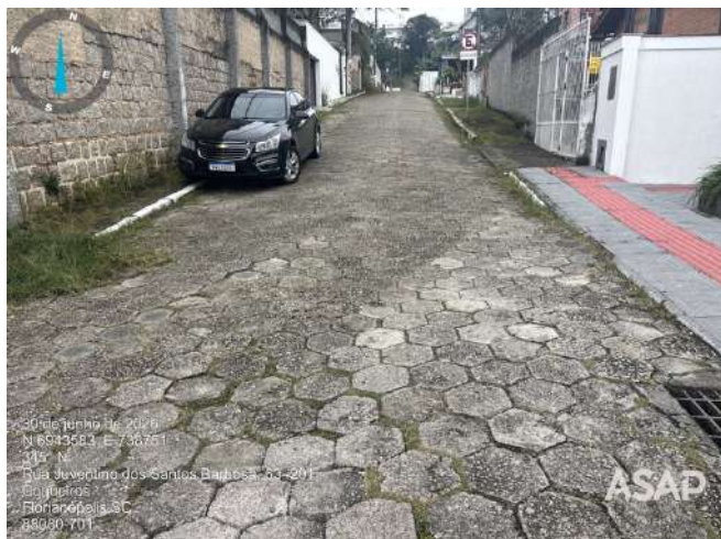
Foto 5.13. Pavimentação em via do bairro Coqueiros. Fonte: ASAP, 2026.
