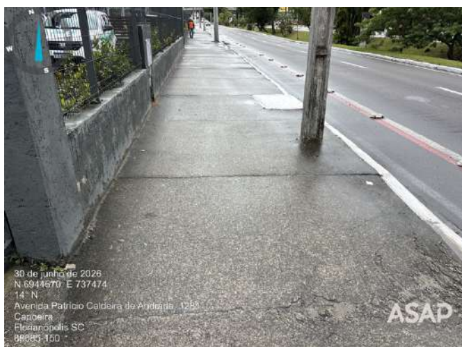
Foto 1.3. Passeio acessível - Av Patricio Caldeira de Andrade. Fonte: ASAP, 2026.
