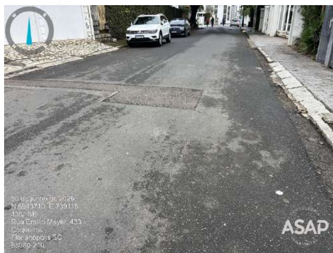
Foto 5.16. Pavimentação na Rua Emilio Meyer. Fonte: ASAP, 2026.
