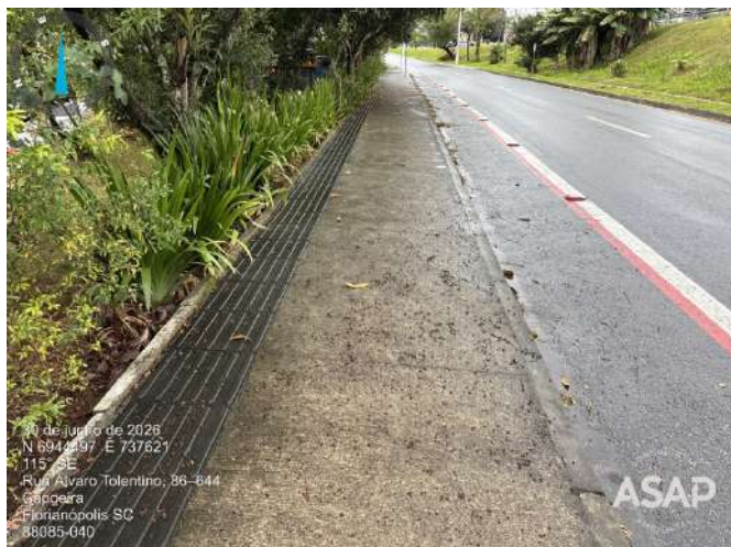
Foto 1.1. Passeio acessível às margens da Rodovia BR 282. Fonte: ASAP, 2026.
