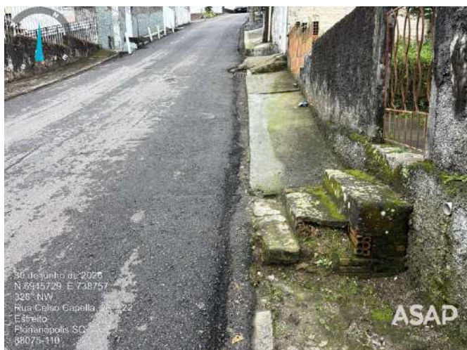
Foto 1.17. Trecho de passeio sem acessibilidade observado junto à Rua Celso Capella. Fonte: ASAP, 2026.
