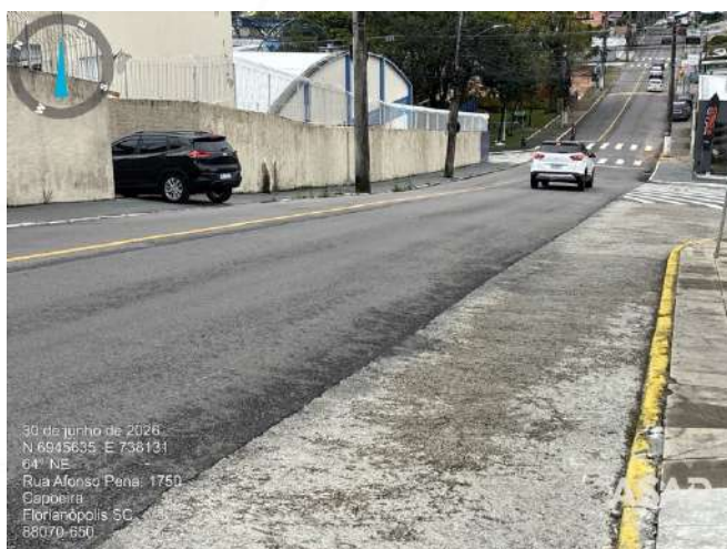
Foto 5.9. Pavimentação na Rua Afonso Pena. Fonte: ASAP, 2026.
