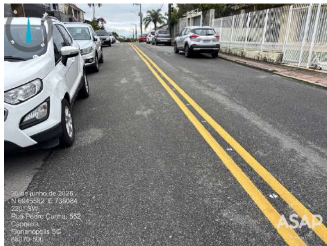
Foto 5.8. Pavimentação asfáltica na Rua Pedro Cunha. Fonte: ASAP, 2026.
