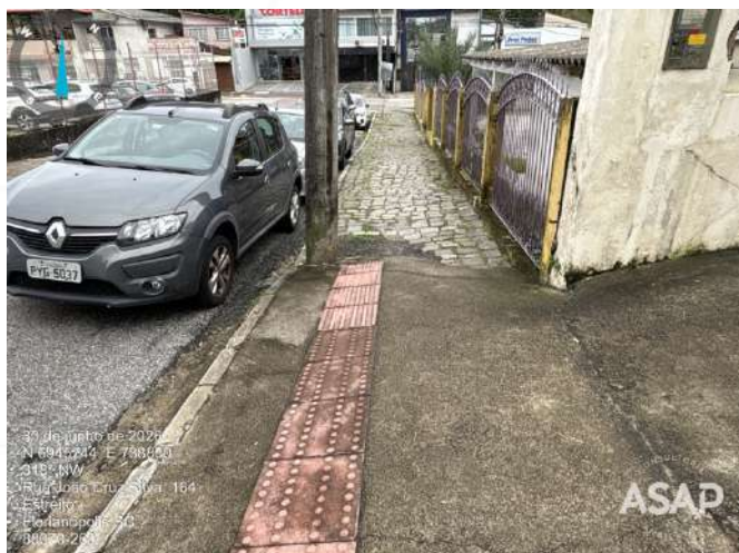
Foto 1.15. Trecho de passeio sem acessibilidade observado junto à Rua João Cruz Silva. Fonte: ASAP, 2026.
