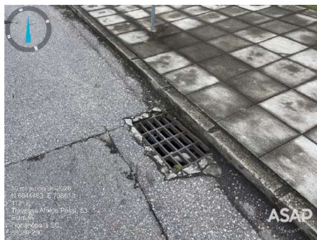
Foto 4.22. Bueiro em bom estado na Travessa Aroldo Pessi. Fonte: ASAP, 2026.
