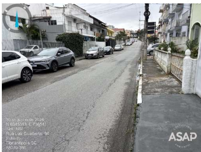
Foto 5.11. Pavimentação na Rua Luiz Gualberto. Fonte: ASAP, 2026.
