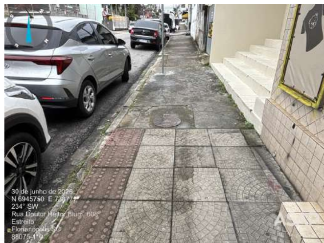
Foto 1.16. Trecho de passeio mal conservado observado junto à Rua Doutor Heitor Blum. Fonte: ASAP, 2026.
