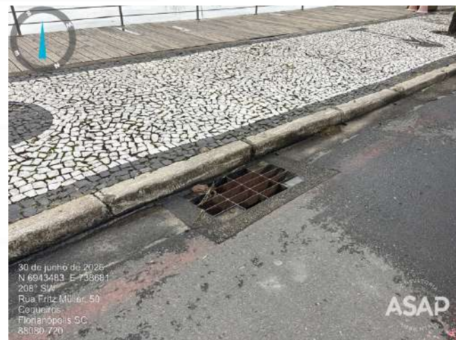
Foto 4.18. Bueiro em bom estado no fim da Rua Fritz Muller, com Rua Desembargador Pedro Silva. Fonte: ASAP, 2026.
