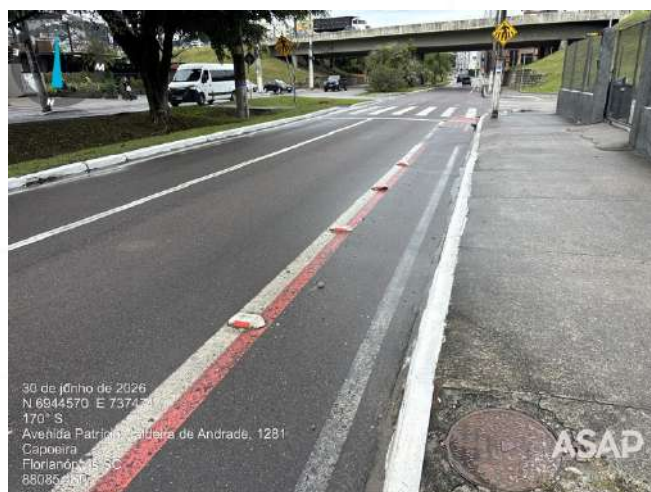
Foto 5.2. Pavimentação na Av. Patricio Caldeira de Andrade. Fonte: ASAP.
