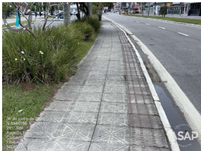
Foto 1.26. Trecho de passeio com acessibilidade observado junto à Av Engenheiro Max de Souza. Fonte: ASAP, 2026.
