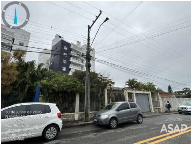
Foto 3.7. Iluminação em LED na Rua Pedro Cunha. Fonte: ASAP, 2026.
