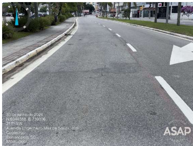
Foto 5.21. Pavimentação asfáltica em bom estado Avenida Engenheiro Max de Souza. Fonte: ASAP, 2026.
