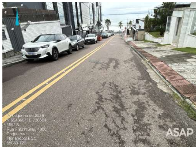
Foto 5.14. Pavimentação na Rua Fritz Muller. Fonte: ASAP, 2026.
