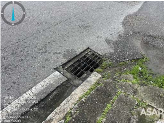
Foto 4.6. Bueiro em bom estado na esquina da Rua Santos Saraiva com Rua Pedro Cunha. Fonte: ASAP, 2026.
